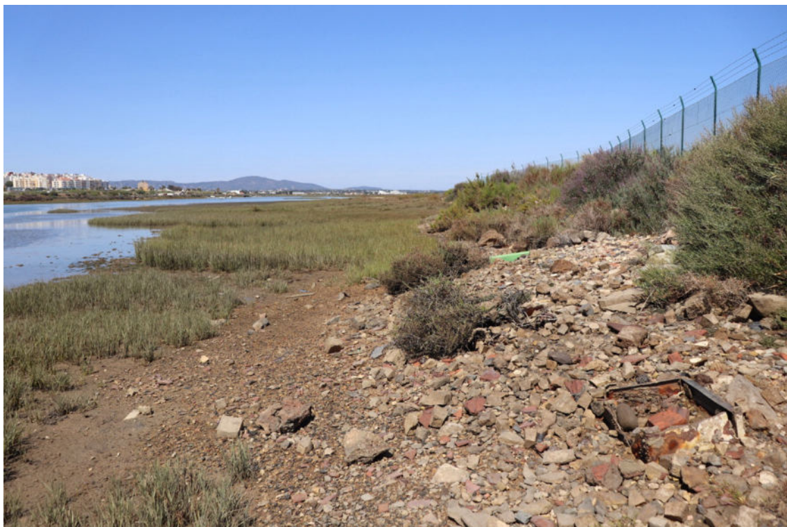
Figura 10 – Imagem obtida no perímetro norte do aterro das instalações do Cais Comercial de Faro. É visível o contacto dos materiais que constituem o aterro com o sapal original
