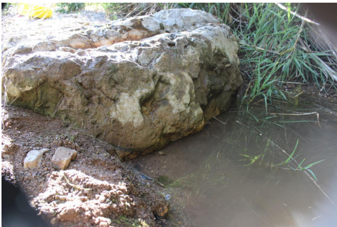
Figura 19 – Vista para norte
