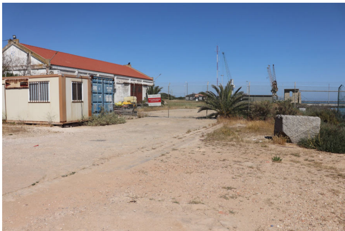
Figura 3 – Zona vedada do Cais Comercial de Faro, no interior da qual se localizará a área destinada aos estaleiros das obras marítimas.
