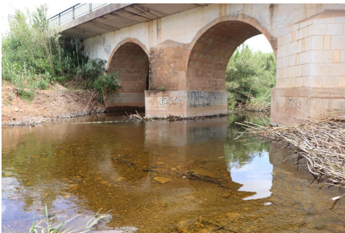
Figura 16 – Aspeto do leito junto à ponte Barão
