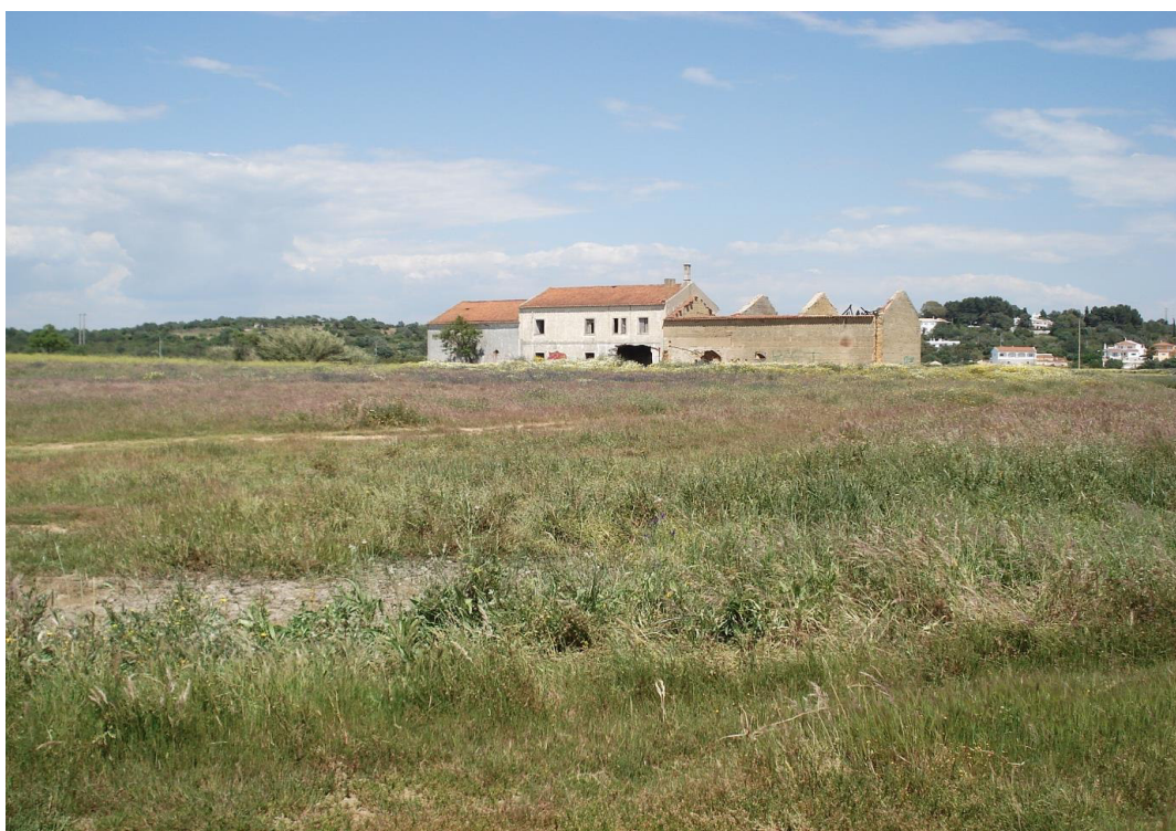
Figura 3.20 – Edifício degradado a reconstruir como Centro de Informação e Interpretação Ambiental.
