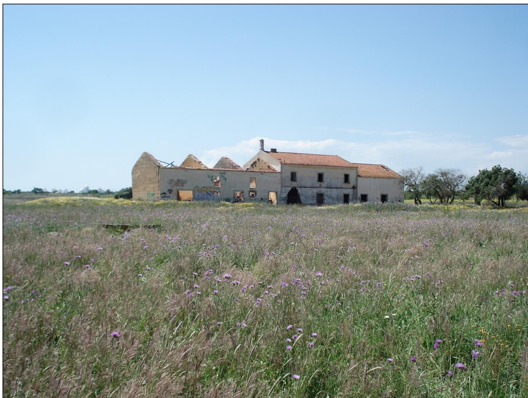
Figura 3.19 – Edifício degradado a reconstruir como Centro de Informação e Interpretação Ambiental.
