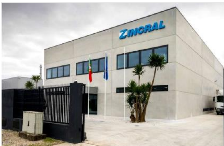
Figura 1 - Unidade industrial da ZINCRAL em Murtosa
