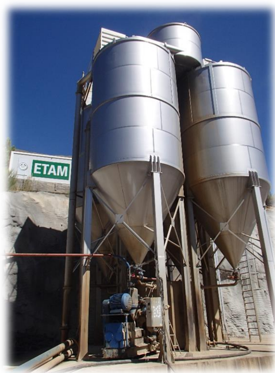
Figura 8 – Instalação de Tratamento de Águas da Mina.
