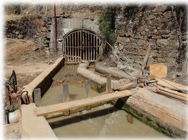
Figura 6- Saída da Galeria da Salgueira.
