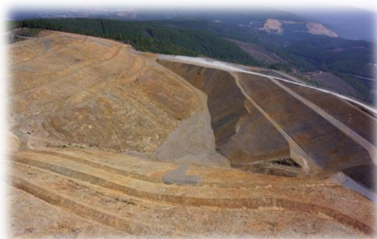
Instalação de resíduos – Célula 2b em construção.
