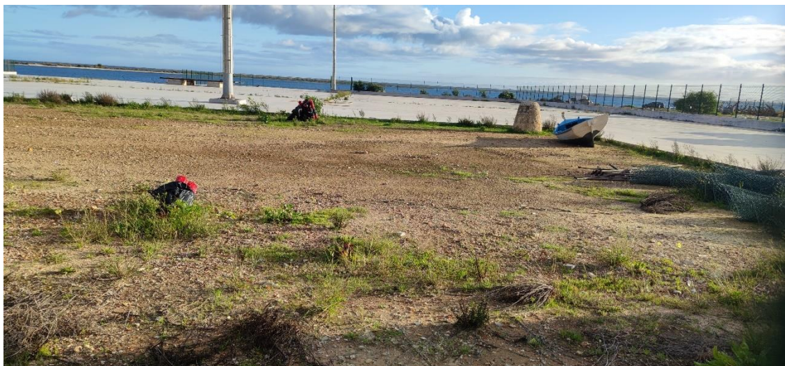
Figura 29 – Pavimento de betão e brita.
