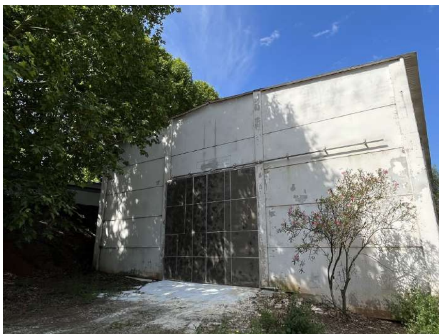
Figura 3.1.4. Pavilhão de armazenamento de estrume
