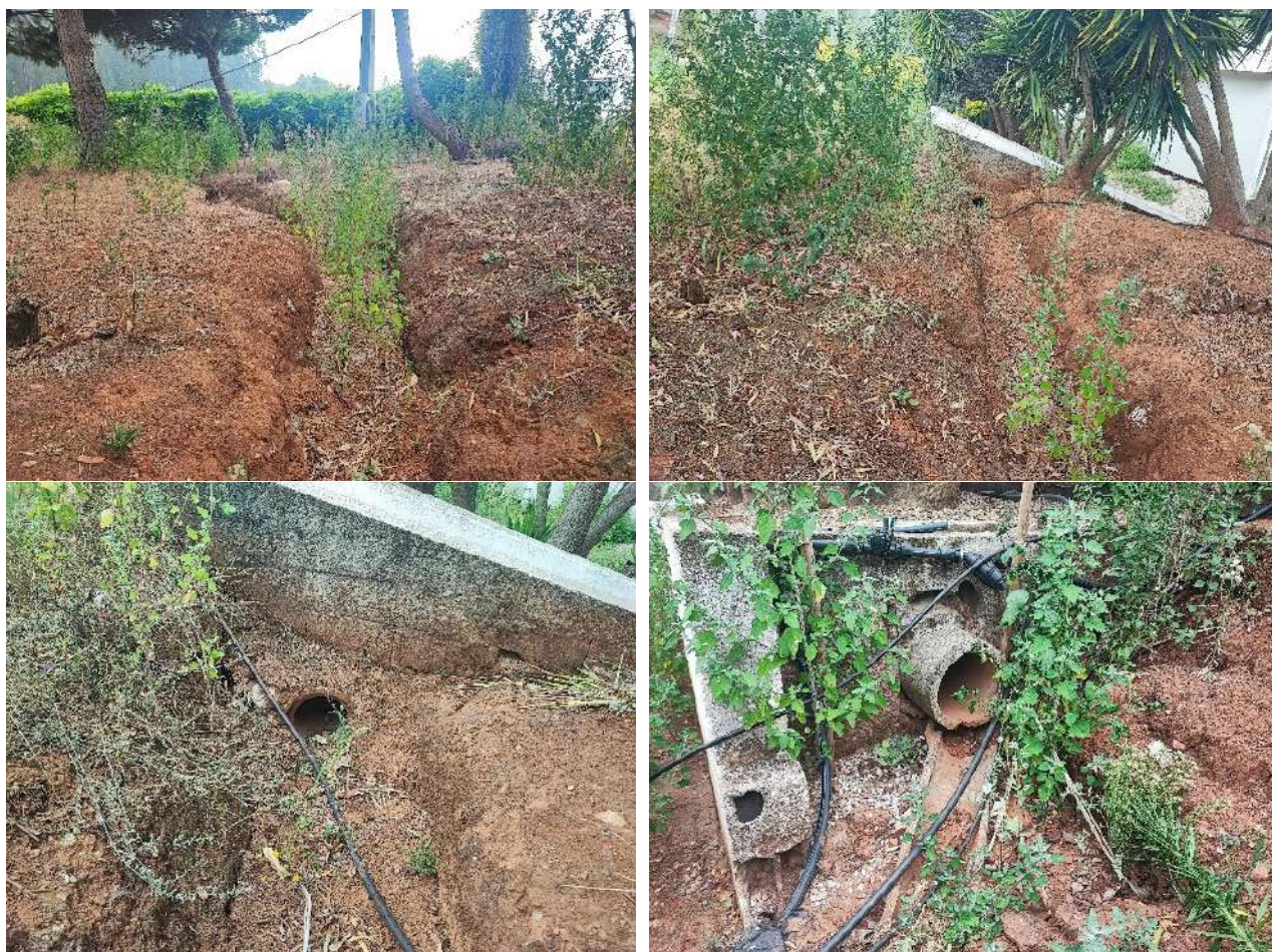
Figura 4.6.5. Vestígios da antiga existência de linha de água LA2, a montante do Pavilhão 1
