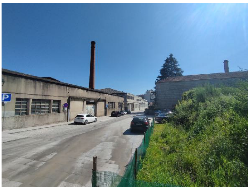
Fig. 126. Fachada principal (rua da Liberdade) e lateral da Fábrica da Madroa resultante do projecto de ampliação de 1926. Fig. 127 e 128. Fachada voltada para a rua da Caldeira conforme projecto de 1949.
