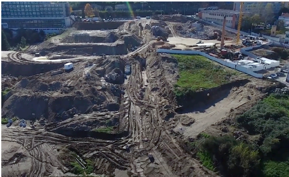
Fig. 147. Vistas do loteamento durante as terraplanagens e colocação de infra-estruturas no dia 11 de novembro de 2020. Guimarães Digital.
