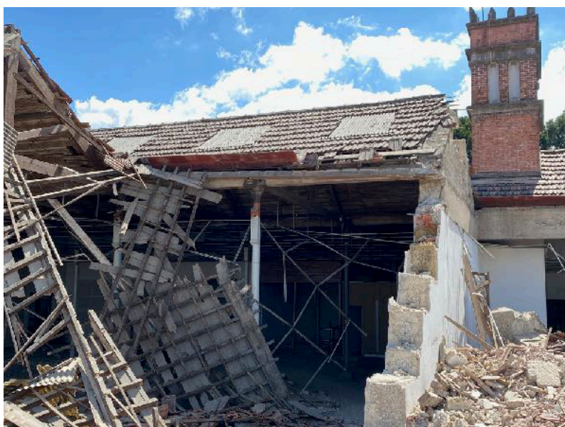
Fig. 24 a 26. Fábrica do Minhoto durante as demolições. Ano de 2020.
