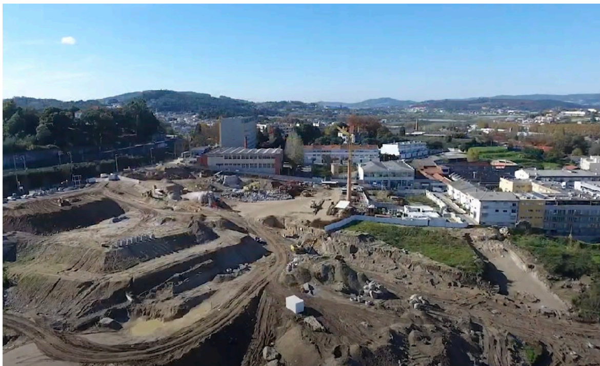
Fig. 145 e 146. Vistas do loteamento durante as terraplanagens e colocação de infra-estruturas no mês de novembro de 2020. Guimarães Digital.
