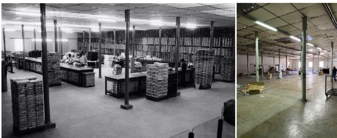
Fig. 21. Interior da Fábrica alguns anos nos anos 60 do séc. XX. Fig. 22. O mesmo espaço antes da demolições, sendo visíveis a estrutura em colunas de ferro de suporte da cobertura.
