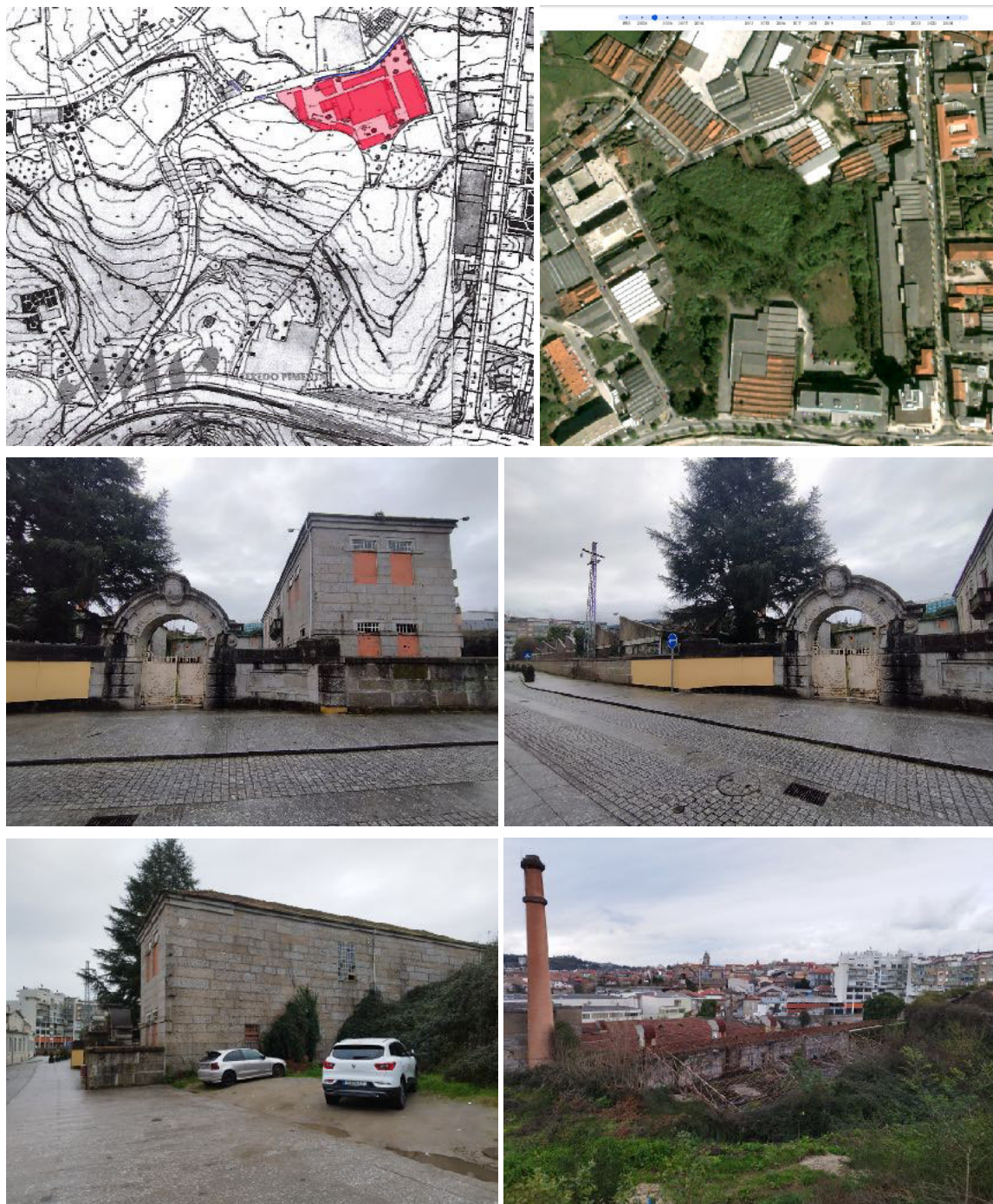
Fig.107. Planta aerofotogramétrica de Guimarães de 1942 com a indicação da Fábrica do Arquinho e o tramo do rio de Couros a céu aberto. Fig.103. Aerofotogrametria da Fábrica do Arquinho do ano de 2005. Google Maps. Fig.108 a 112. Fachada da fábrica voltada para a rua da Caldeiroa e fachada lateral. Nave central com as tesouras metálicas à vista e a chaminé como elemento vertical de destaque.
