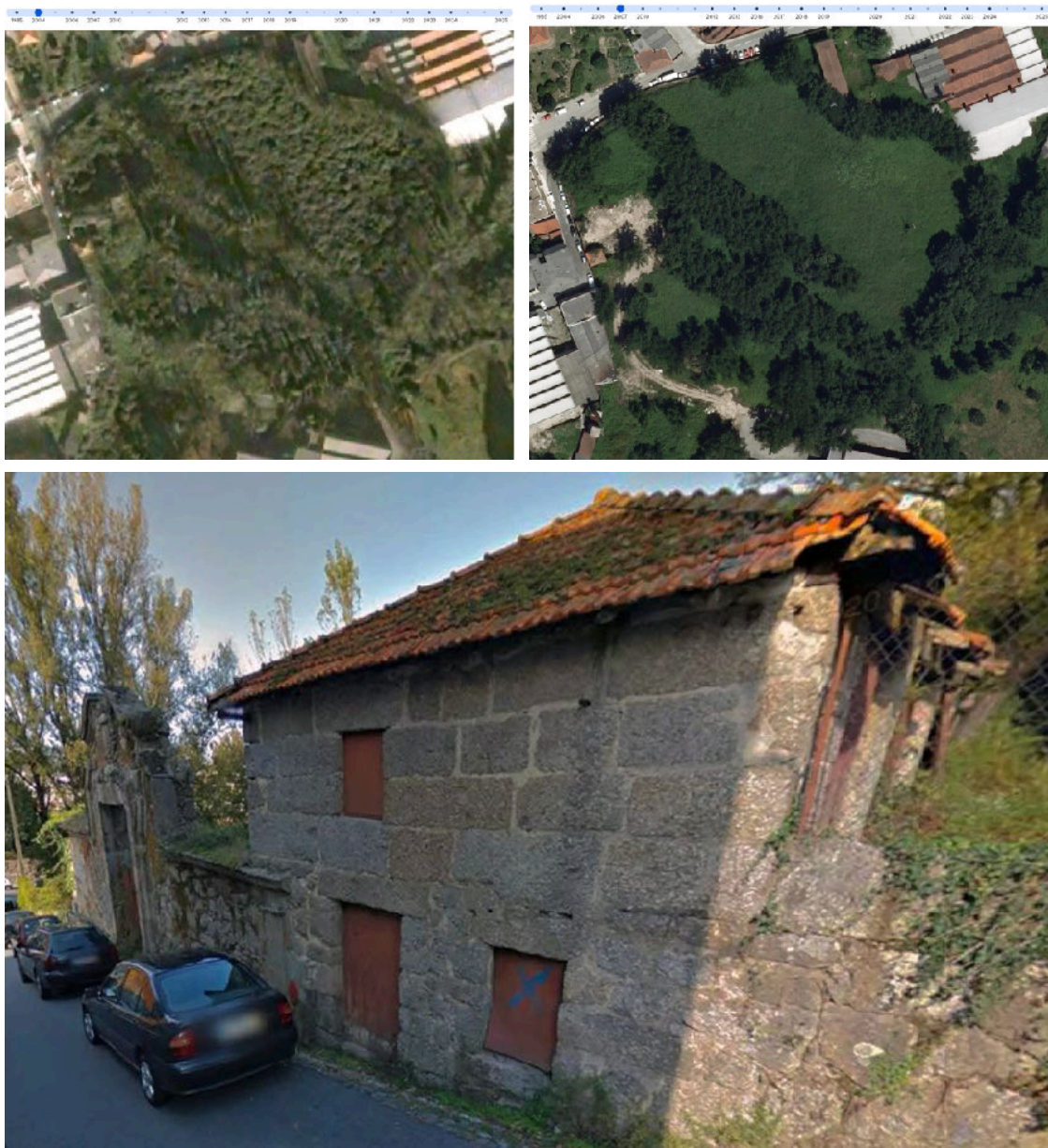
Fig. 6. Google Maps, 2004. Fig. 7. Google Maps, 2007. Fig. 8. Portão de entrada à quinta e Fachada do edifício de apoio.
