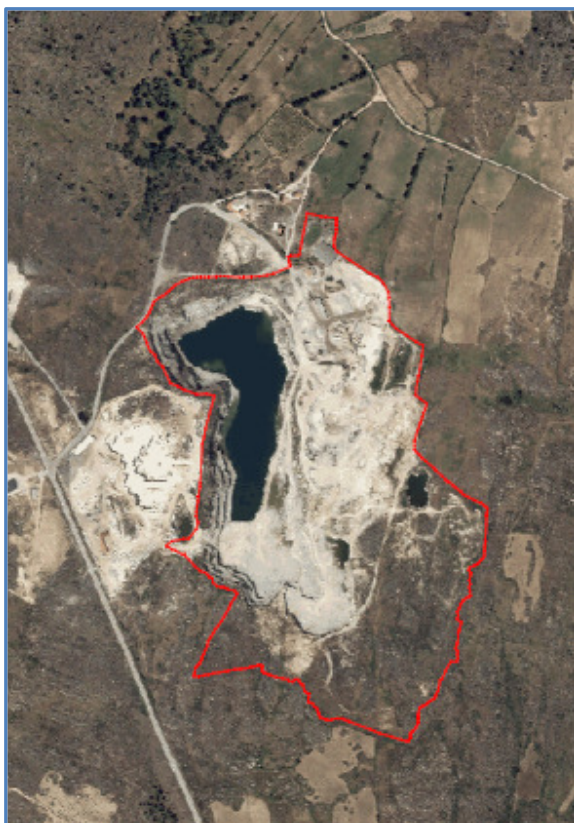
Fotografia nº 1: Fotografia aérea (sem escala); Área a licenciar (cor vermelha); A área intervencionada a poente da área a licenciar corresponde à área da pedreira contígua n.º 6781 denominada Senhora da Ajuda
