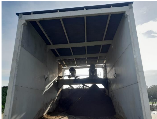
Figura 1 – Fotografia tirada após a ampliação da área coberta da nitreira
