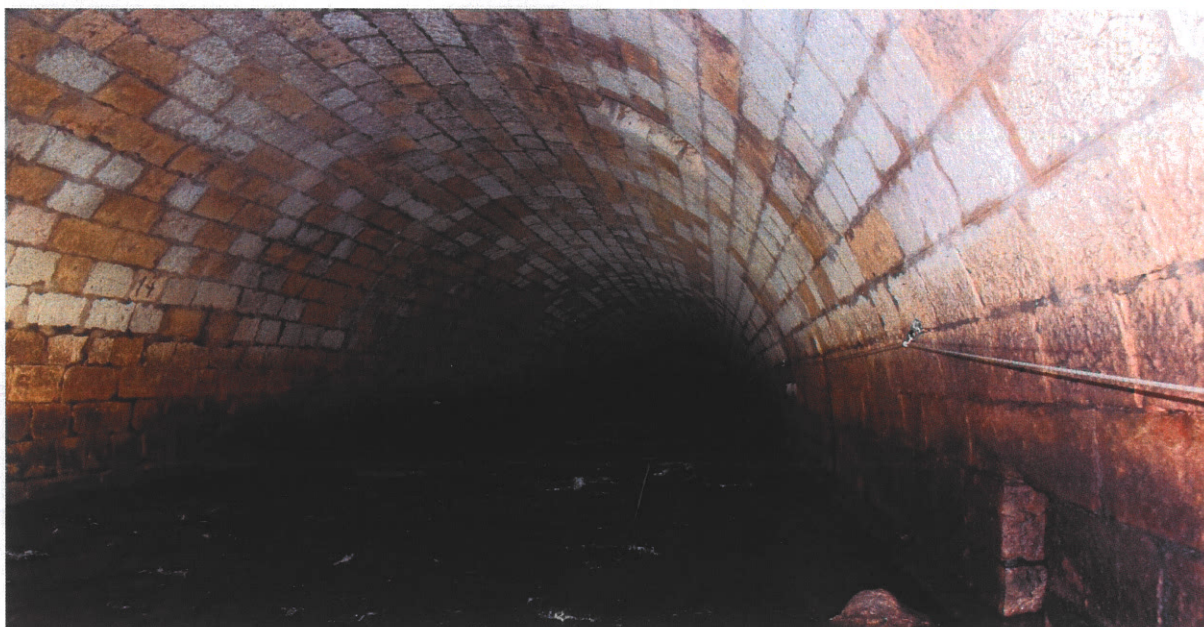
Fotografia 1 – Vista do caneiro para jusante, a partir da secção de entrada da visita
