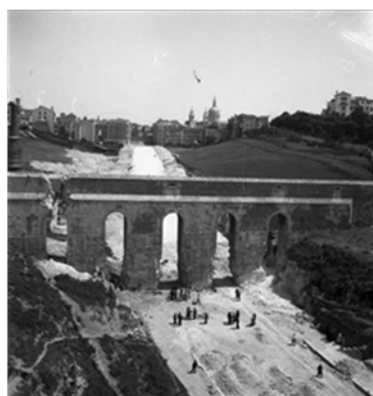
Demolição do troço do Aqueduto para a abertura da avenida I.S., Judah Benoliel, 1949 (PT/AMLSB/CMLSBH/PCSP/004/JBN/004154)
