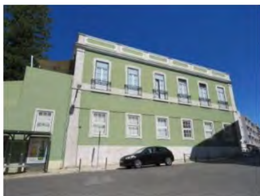
Edifício nas traseiras do qual o futuro túnel se cruzará com o aqueduto.
