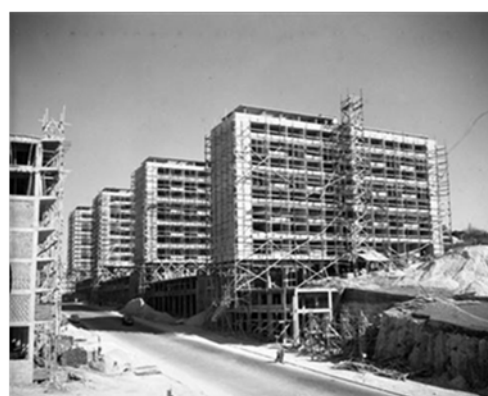
Fotografia dos prédios em construção, de Armando Maia Seródio, 1956 (PT/AMLSB/CMLSBAH/PCSP/004/SER/001116).
