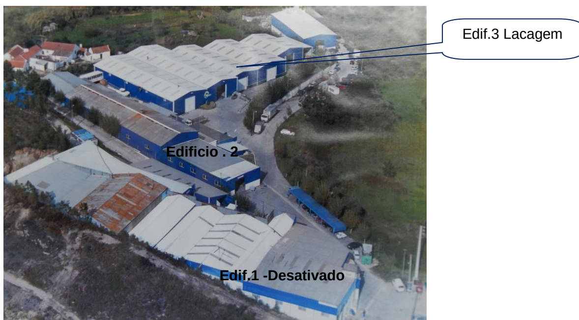
Figura 6 – Vista Atual da instalação
