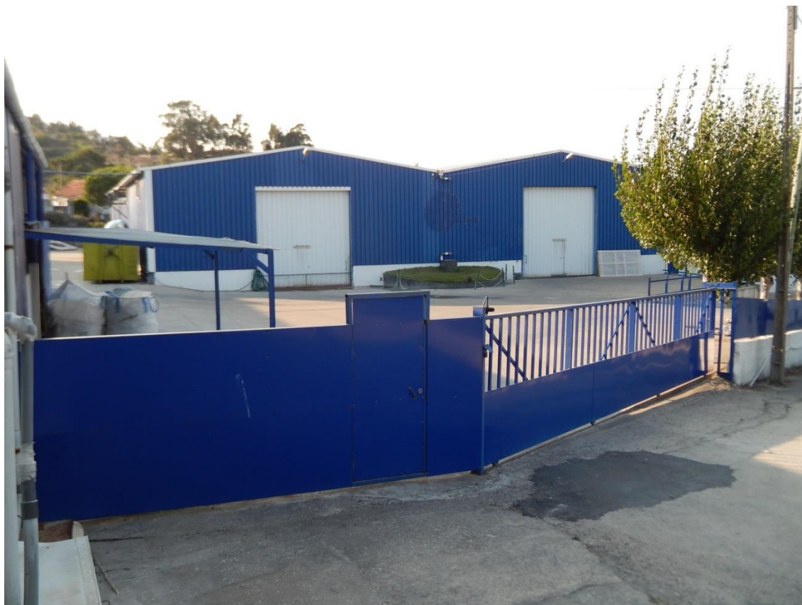
Figura 28 – Edifício 3 – Edifício da Lacagem – Entrada da instalação
