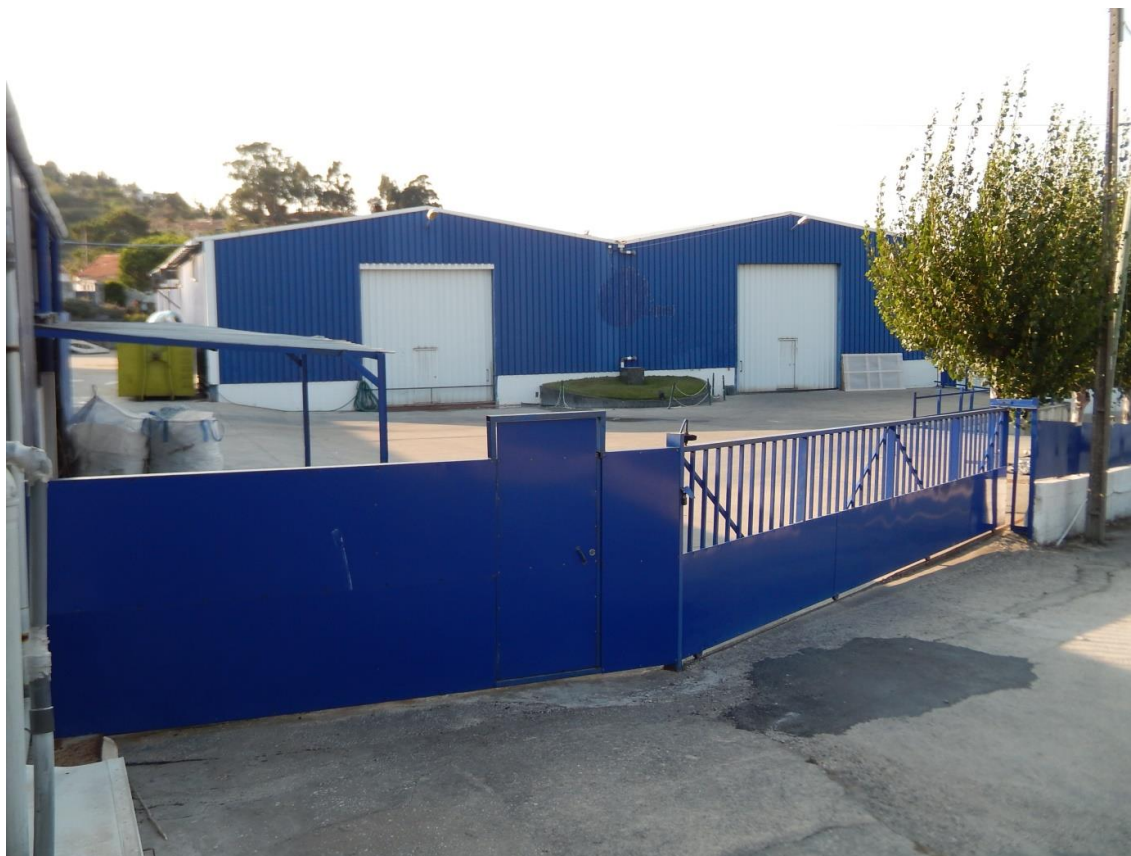
Figura 8 – Edific. 3 – Lacagem – Entrada da Instalação
