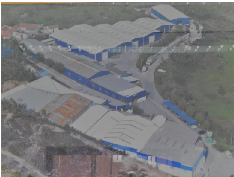
Figura 2 – Vista Aérea da Instalação
