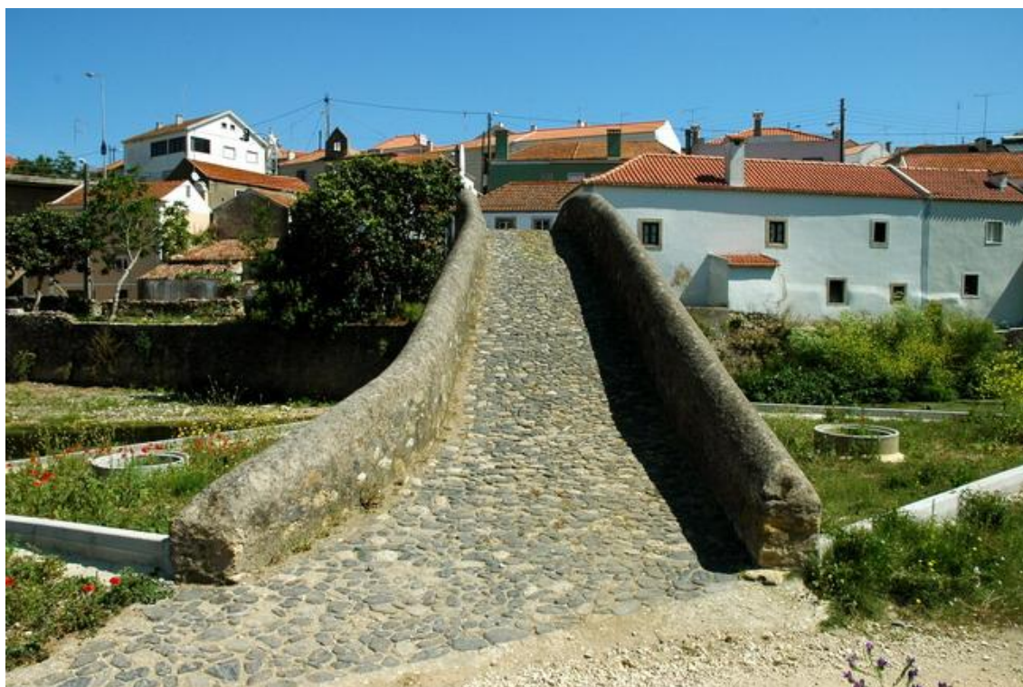
Figura 68–Ponte Medieval de Cheleiros – Pavimento/Guardas
