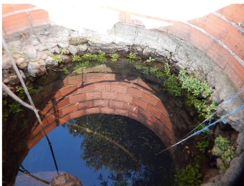
Figura 51- Poço de água na vizinhança da área da instalação.
