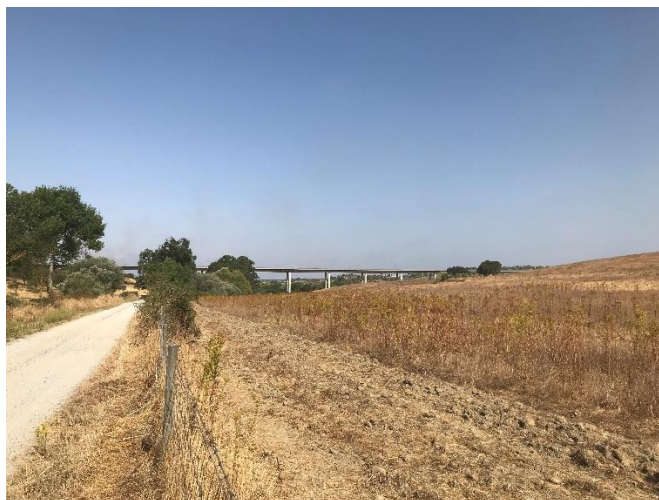
Figura 10.1 – Ponte do IC13
