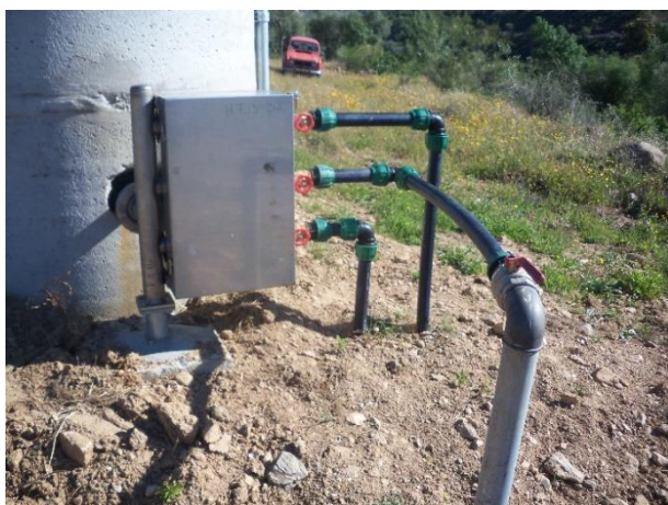
Figura 9.1 - Contadores individuais instalados em perímetros de rega na região norte
