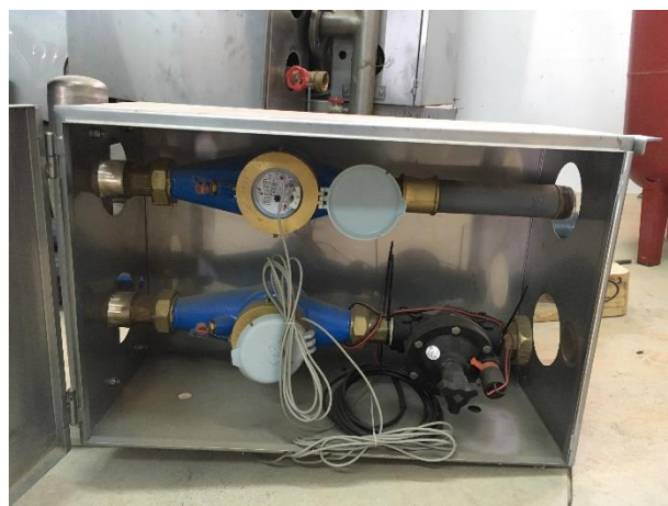
Figura 9.1 - Contadores individuais instalados em perímetros de rega na região norte
