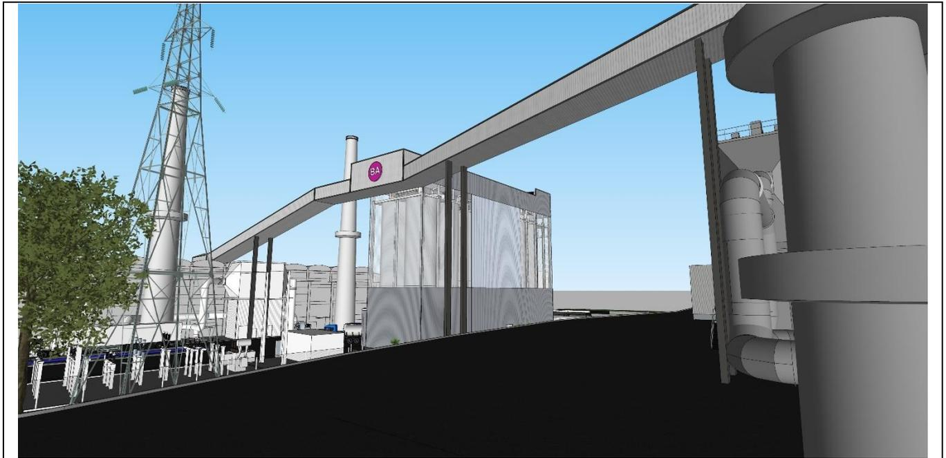
**Figura 5.132 – Simulação tridimensional da entrada do projeto após a execução da instalação do novo forno (AV6), do novo edifício da composição e da nova chaminé**
