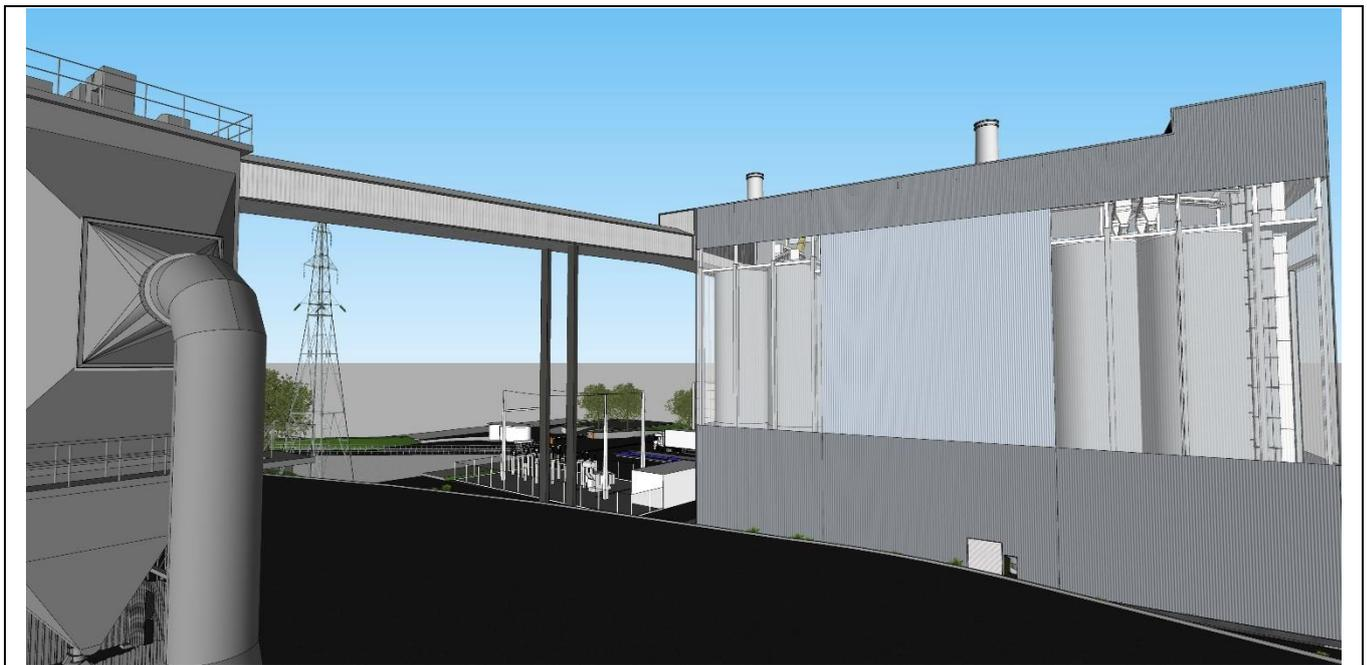
**Figura 5.135 – Simulação tridimensional do projeto após a execução da instalação do novo forno (AV6), do novo edifício da composição e da nova chaminé**
