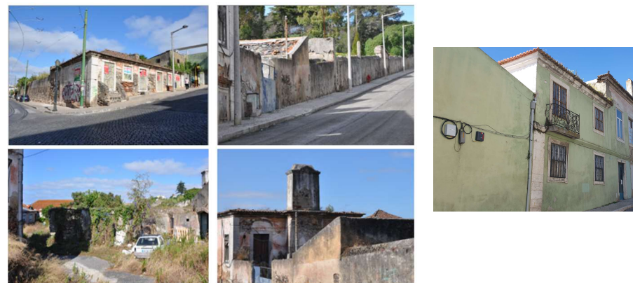
Edifícios a demolir
