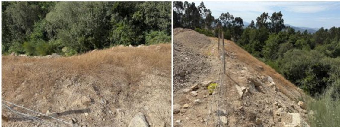
Figura 1: Fotos área a Norte
