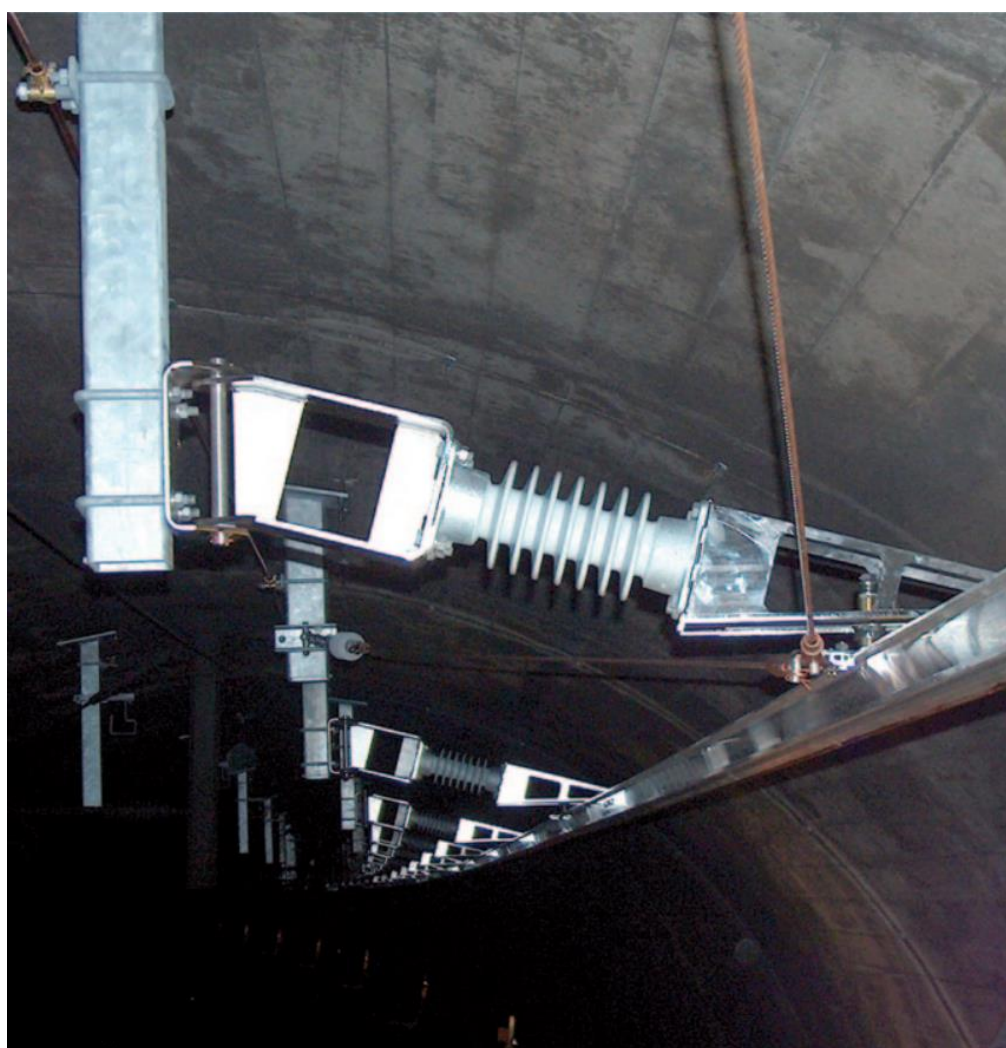
Figura 24 – Fotografia de exemplo da Linha de Contacto Rígida do fabricante Furrer+Frey
