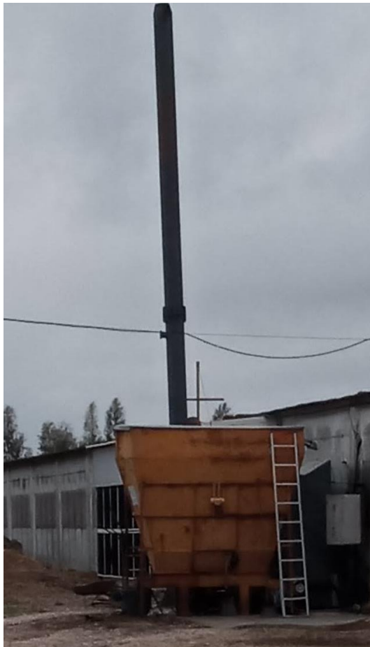
Ilustração 1 e 2- Caldeira para produção de calor
