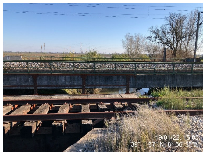
Linhas descendentes sobre extremidade de nascente
