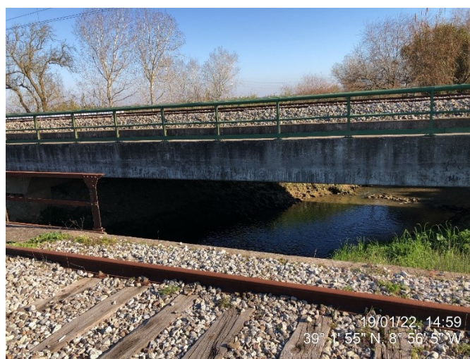
Linhas descendentes sobre extremidade de nascente
