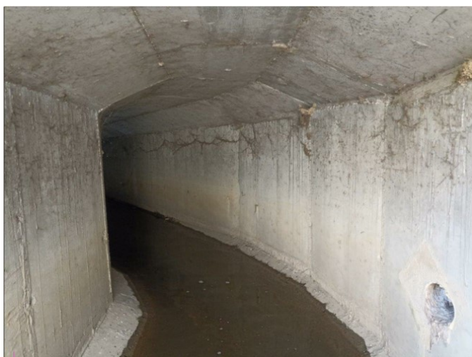
Extremidade de nascente. Caixa a ponte do AMV 14
