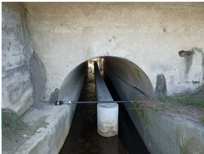
Extremidade de poente da galeria sob as VA
