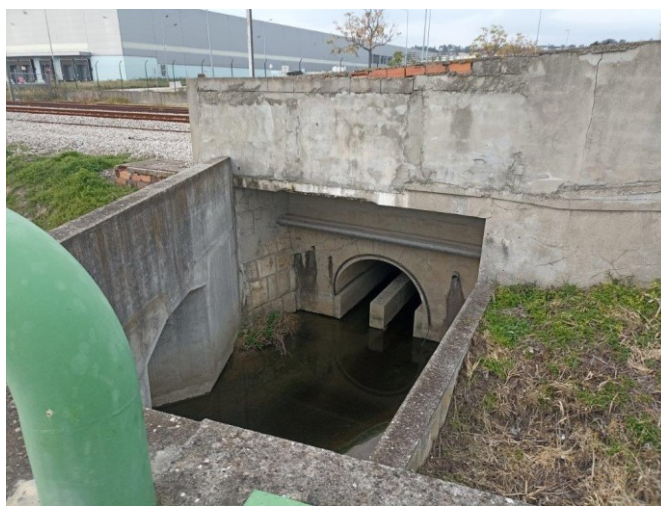
Extremidade de nascente da galeria sob as VA. Derivação para a galeria de drenagem sob as VD
