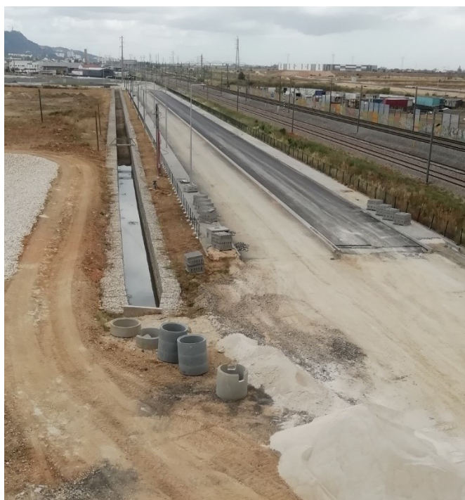
Canal de drenagem anexo à bacia de retenção em construção a poente da PH114/115
