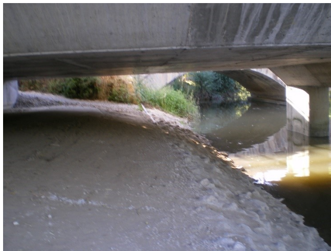
Extremidade de nascente da ponte de arcos, por baixo da ponte das vias descendentes
