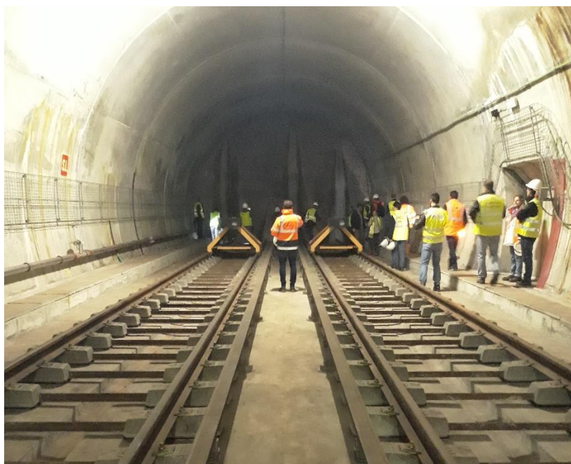
Figura 4 - Término: Tímpano existente (Foto: COBA, 23 de fevereiro de 2023)
