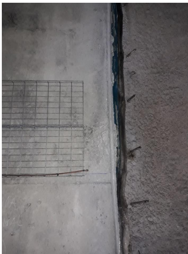
Figura 7 – Sistema de impermeabilização existente (Foto: COBA, 23 de fevereiro de 2023)
