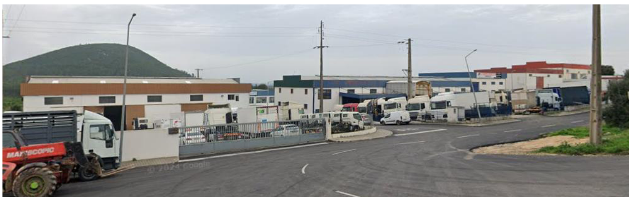
Fotografia 8.2 – Edifícios de cariz industrial atualmente existentes na povoação de Marés
