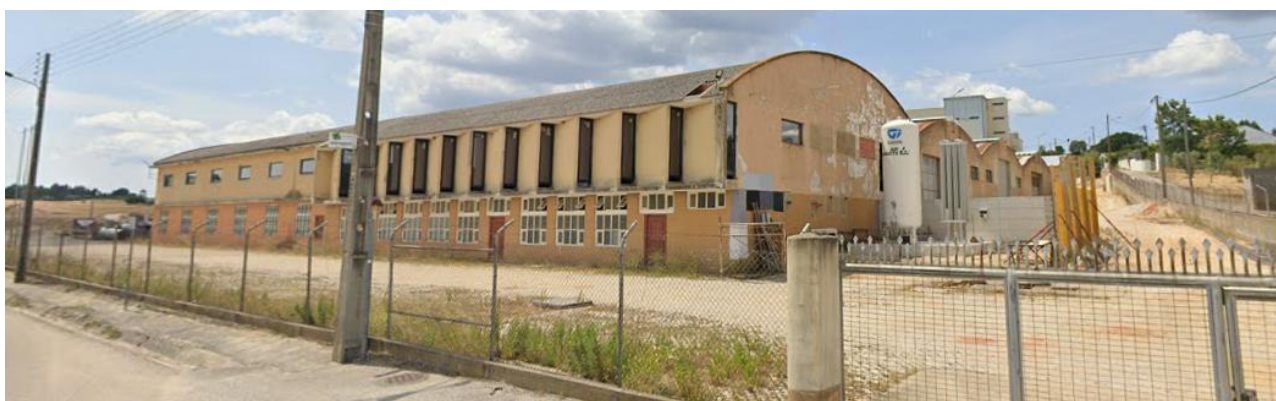
Fotografia 8.1 – Edifícios de cariz industrial atualmente existentes na povoação de Marés
