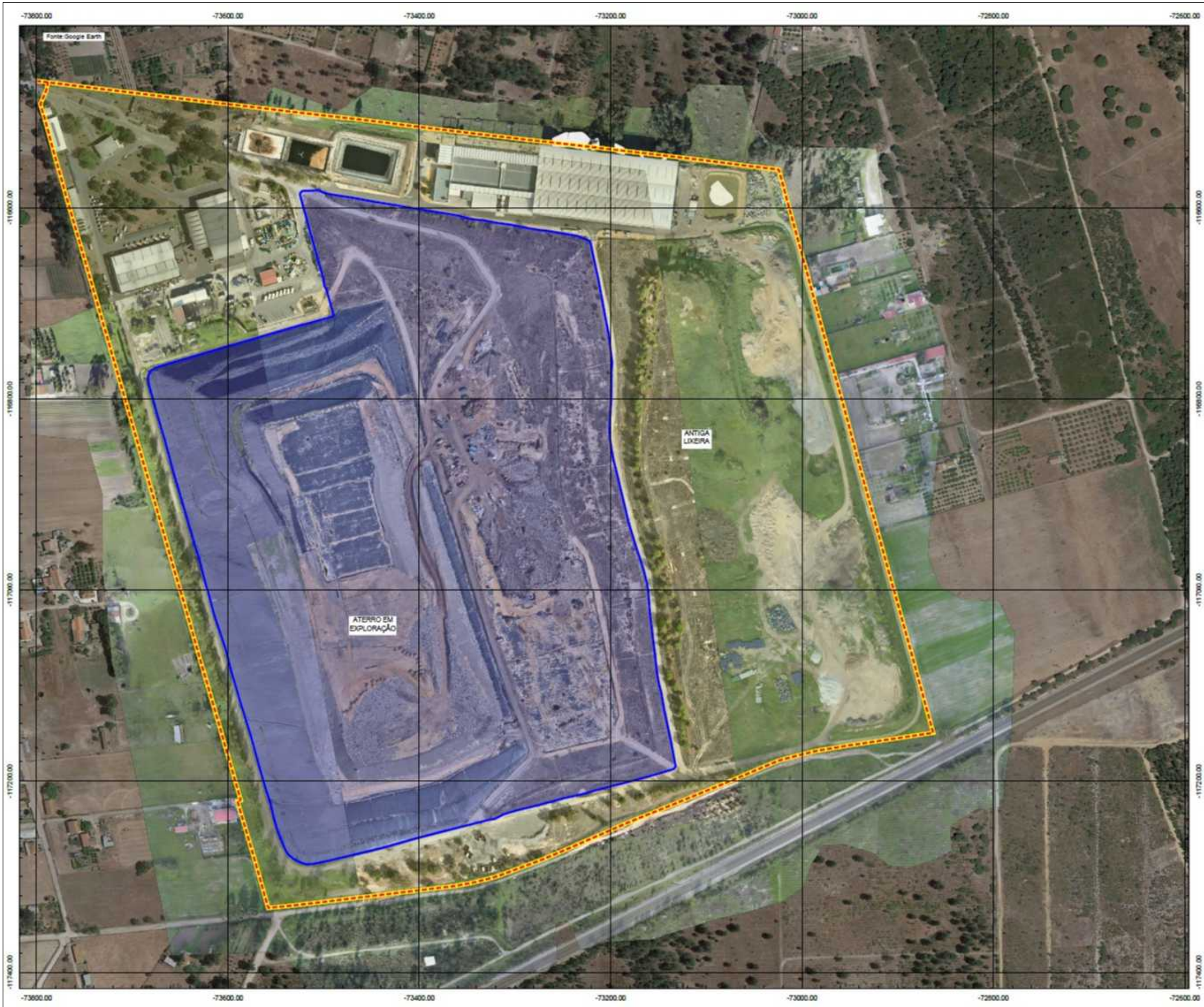
ATERRO SANITÁRIO DE PALMELA
