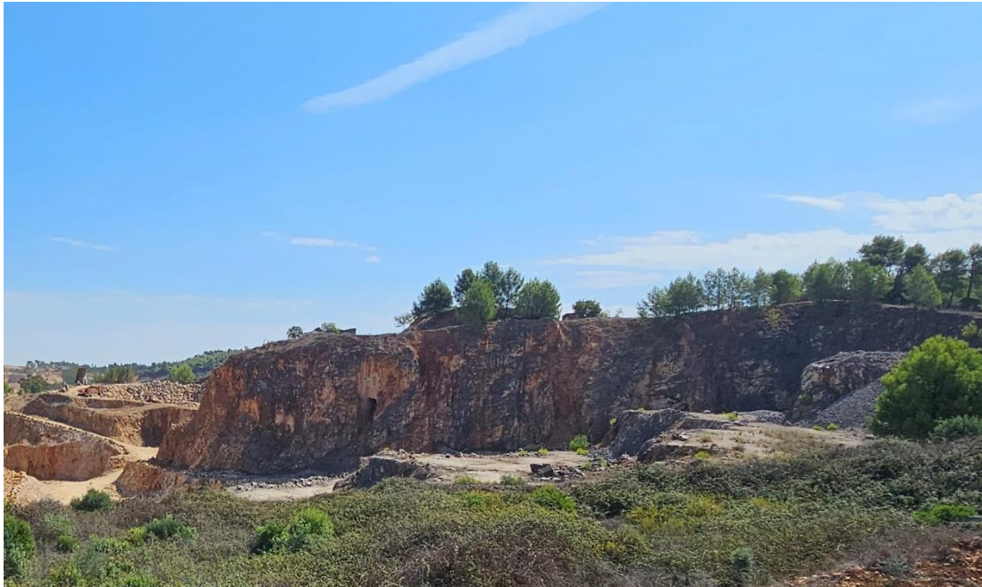
Figura III.21 – Perfil de um talude de escavação onde é patente a tipologia delgada e esquelética dos solos.
