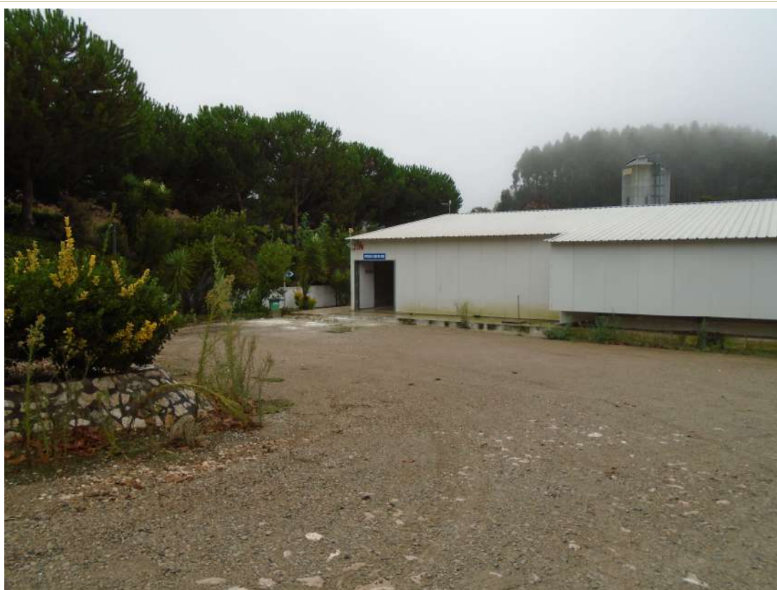
Figura 9 – Vista geral do pavilhão 1 (AID) - Área 1.
