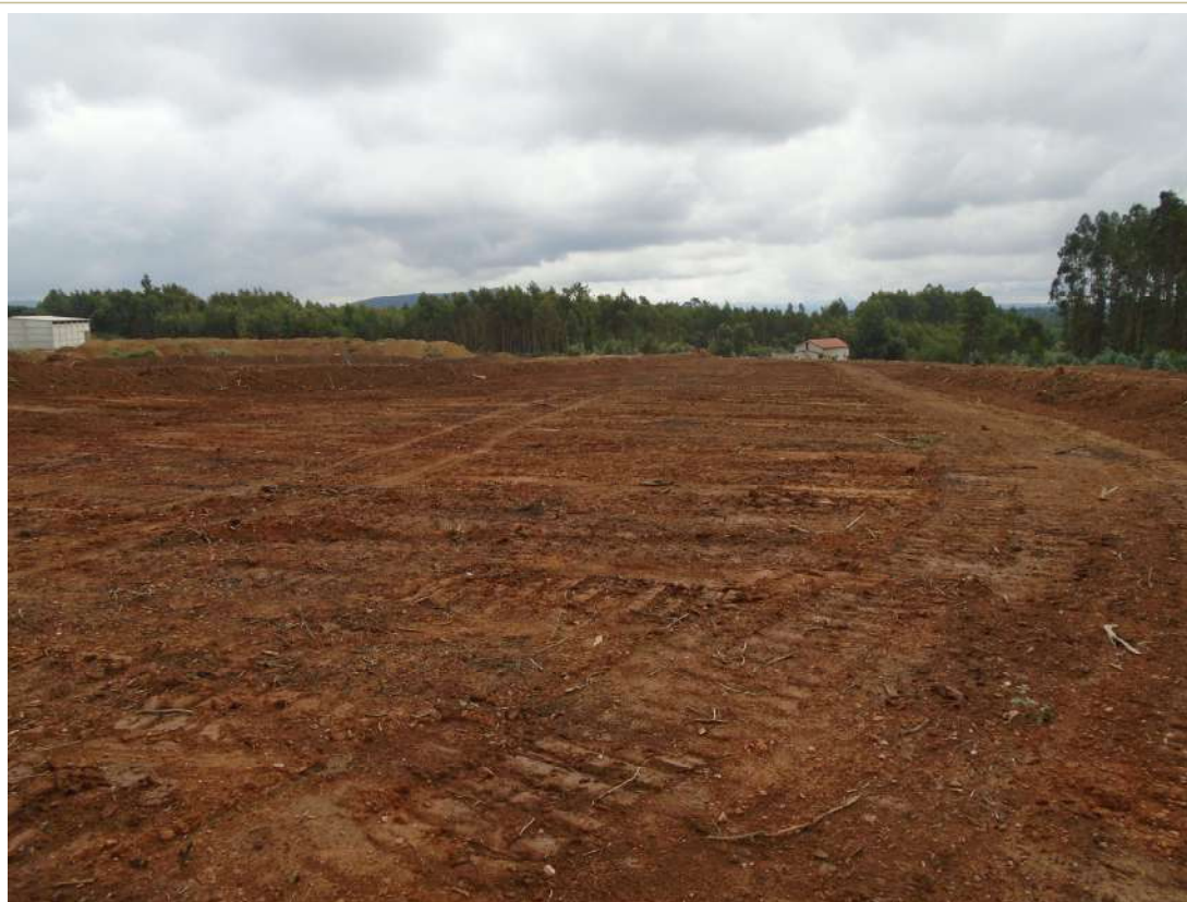
Figura 27 – Vista para Este (All) – Área 5.
