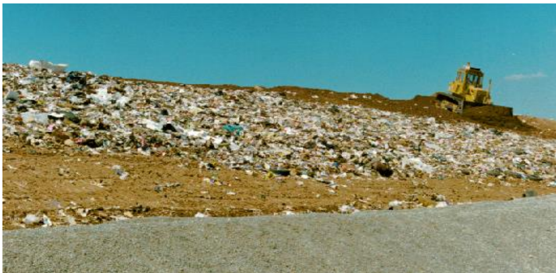
Figura 8: Instalação da cobertura diária numa frente de trabalho.
