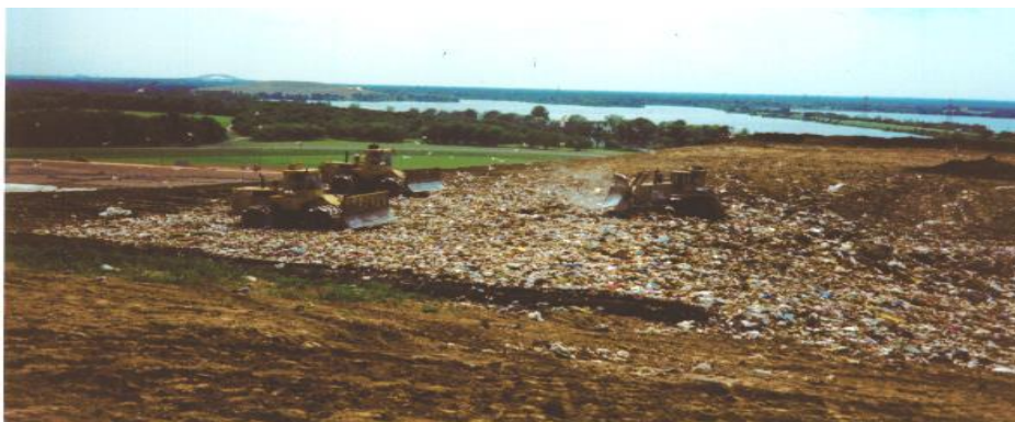
Figura 2: Compactação de resíduos com compactadores tipo Pés de Carneiro e apoio de Pá de Rastos.
