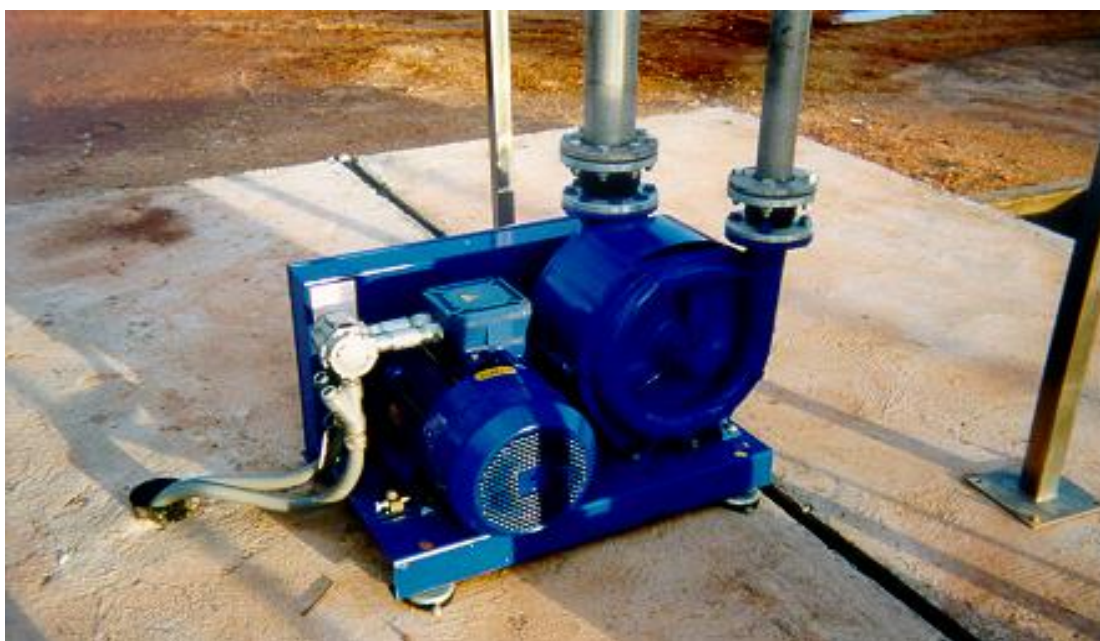
Figura 17: Grupo aspirante do tipo centrífugo.
