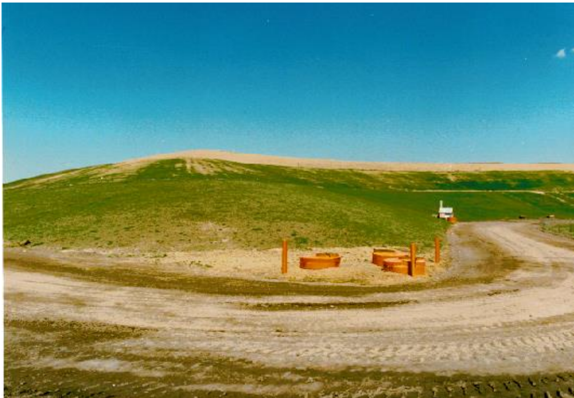
Figura 9: Aspecto da cobertura intermédia.
