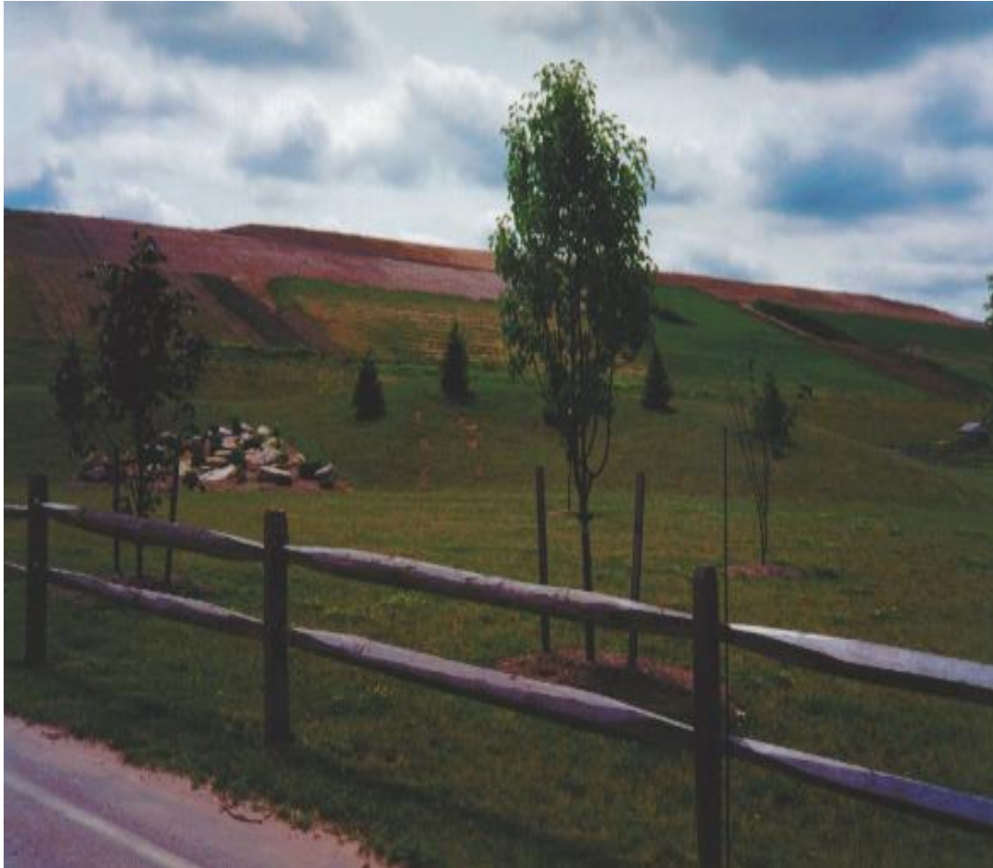
Figura 10: Talude de um aterro onde está a ser aplicada a camada de selagem final.
