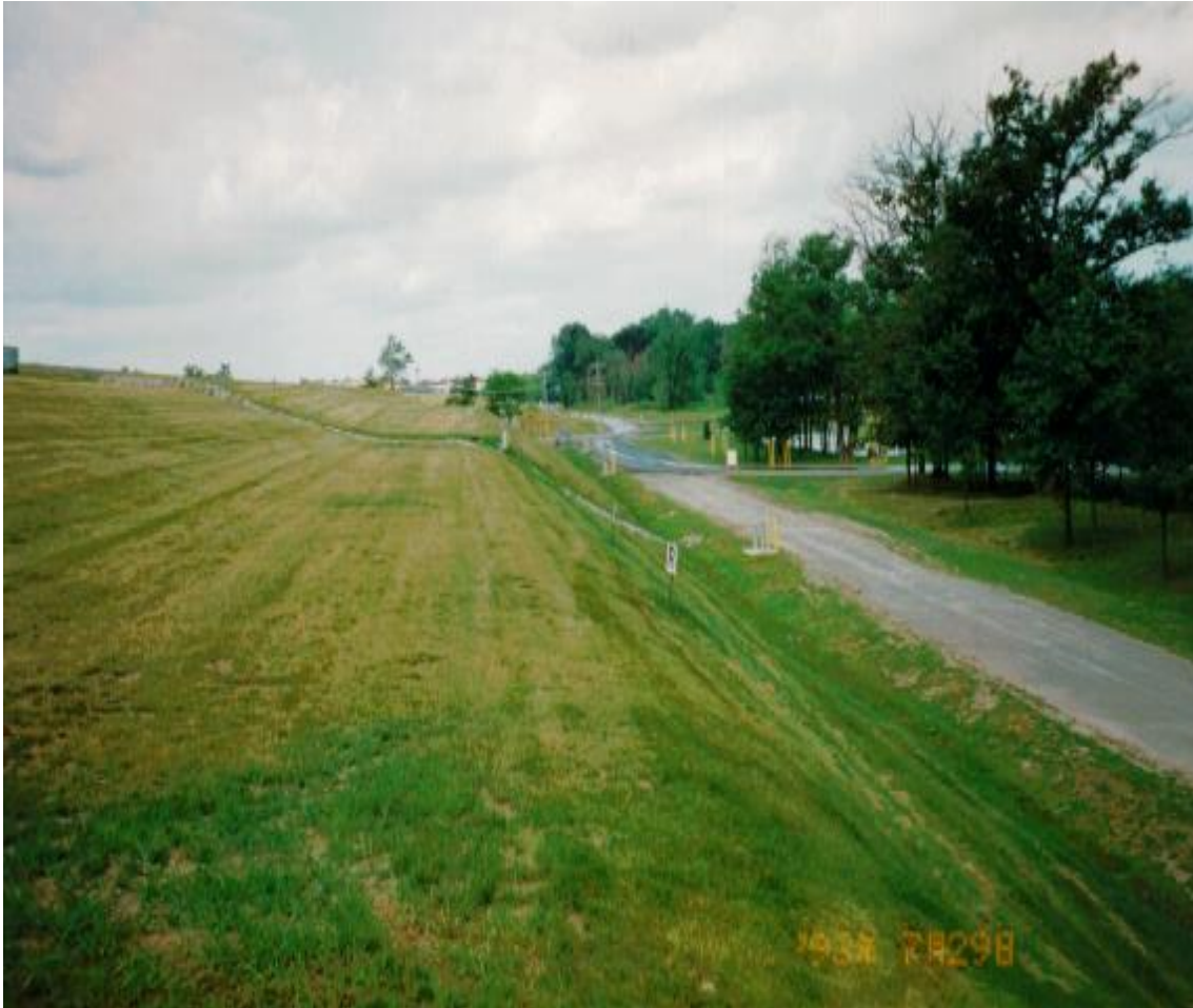
Figura 12: Vala de drenagem revestida com erva.
