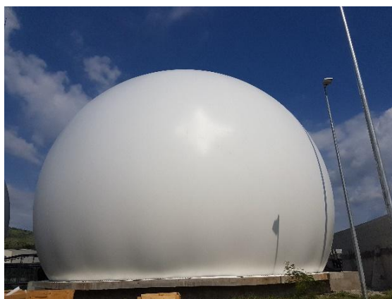
Figura 4 - Exemplo de um gasómetro de chão
