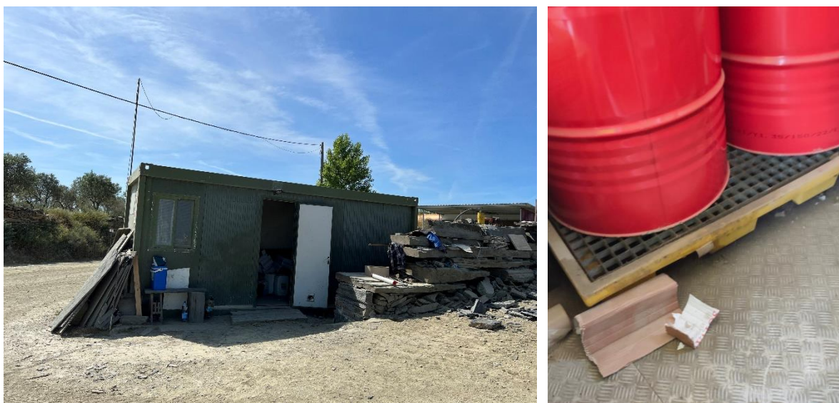
Figura 22. Contentor onde é atualmente efetuado o armazenamento dos óleos e detalhe do sistema existente.
