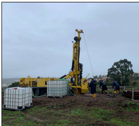
Figura 11. Sonda hidráulica modelo Mustang 5-P4 (Sondagem S7).
