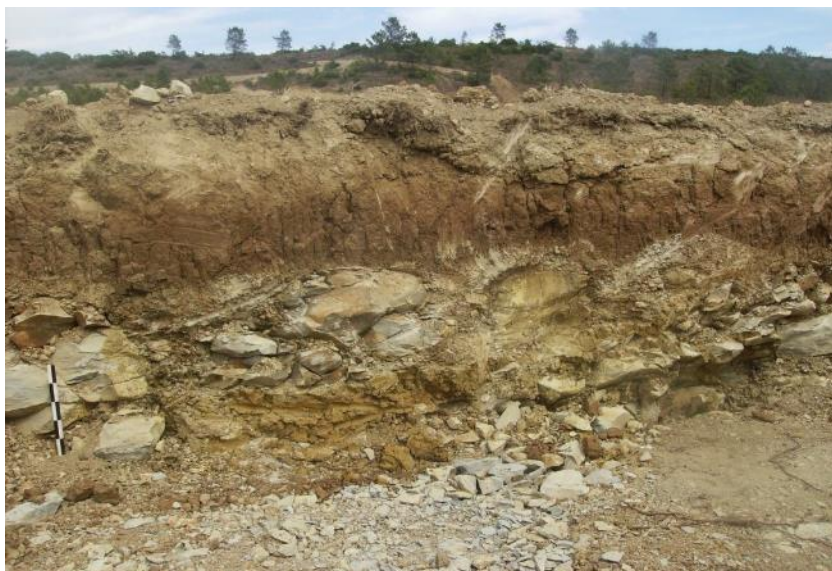
Figura 4.8.2. Perfil do solo na área de projeto (Fotografia tirada durante as operações de preparação do terreno para a construção da instalação avícola da Quinta da Póvoa).
