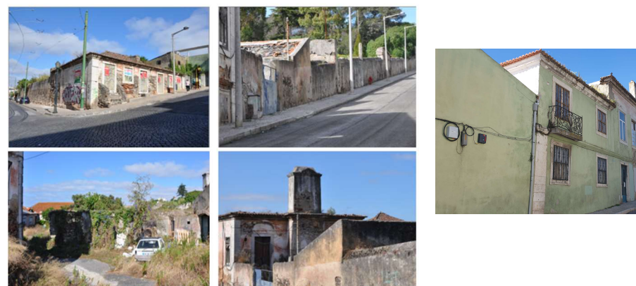
Edifícios a demolir
