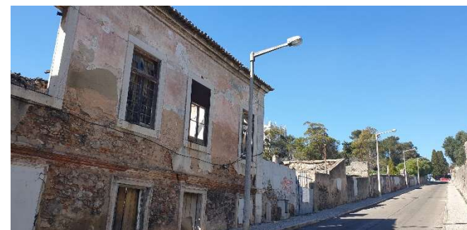
Edifício a recuperar
