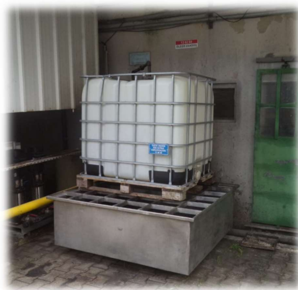
Figura 13 – Local de armazenagem do resíduo perigoso RP1 – Óleos Minerais Usados
