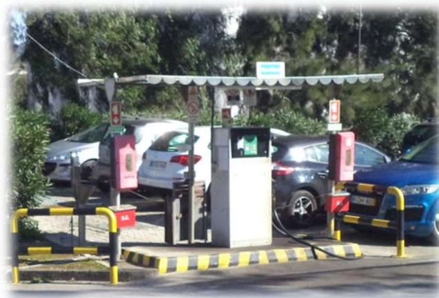
Figura 15 - Local de trasfega de S16 – gasóleo
