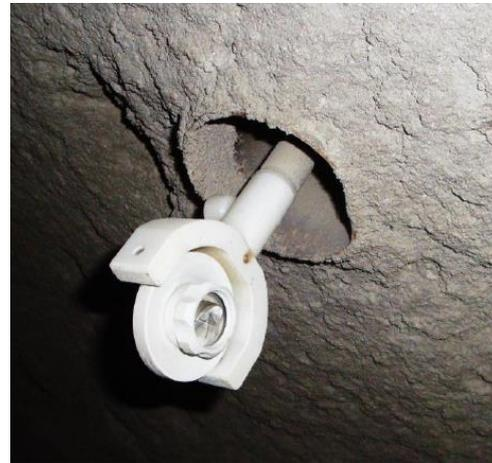
Figura 15 – Prisma de convergência
