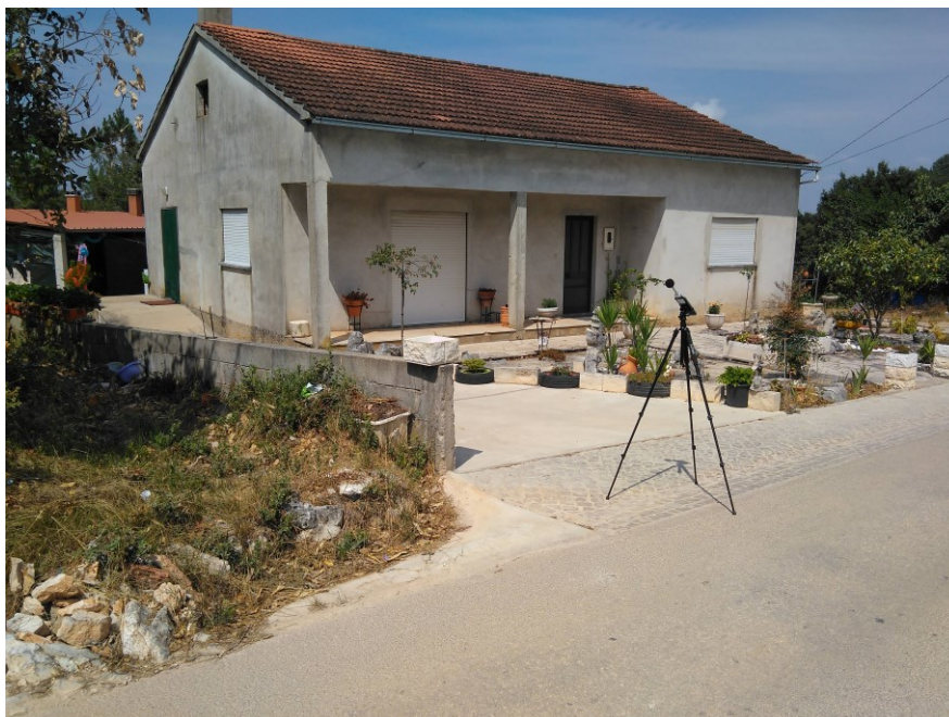
Fig. 3 – Ponto de medição R3 a NE
