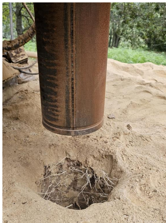
Fotografia 1 e 2 – Início dos trabalhos de perfuração; Colocação do tubo de aço carbono 220mm.
