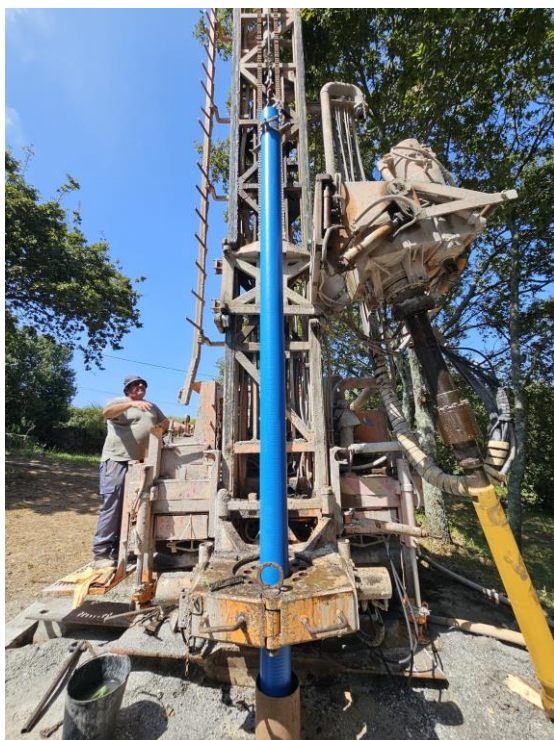
Fotografia 11 e 12 – Colocação da coluna de revestimento de pvc georoscado reforçado de 160mm; Equipamento de apoio à obra.
