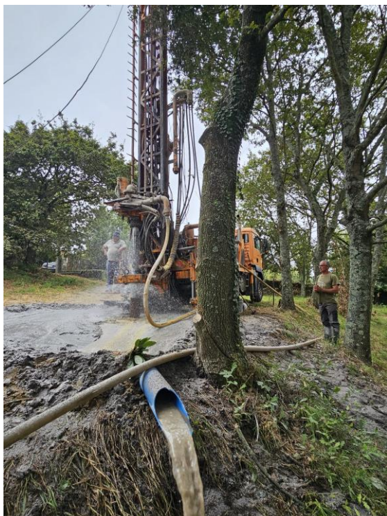
Fotografia 9 e 10 – Caudal registado no final dos trabalhos de perfuração (8000 L/h); Coluna de revestimento de pvc georoscado reforçado de 160mm.
