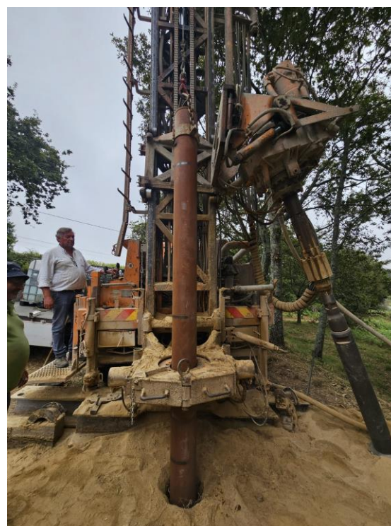
Fotografia 3 e 4 – Trabalhos de soldadura e colocação dos tubos de aço carbono.
