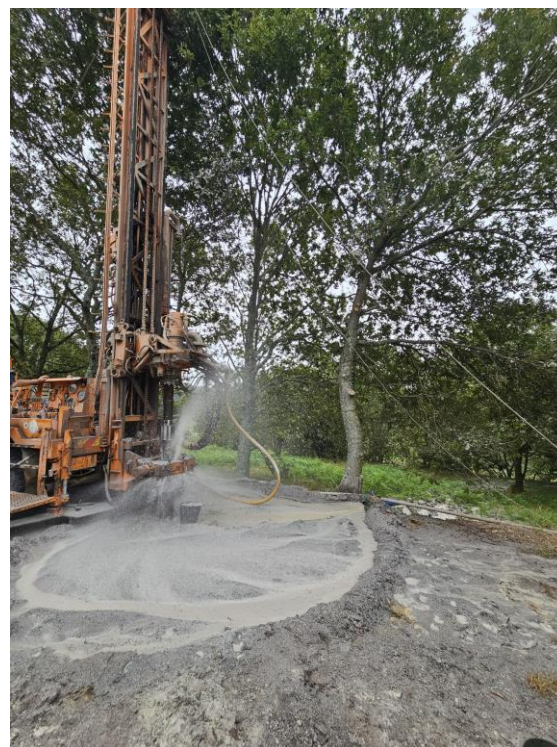
Fotografia 7 e 8 – Trabalhos de perfuração, nível produtivo intersetado
