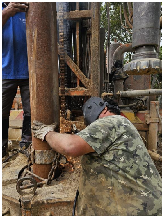
Fotografia 3 e 4 – Trabalhos de soldadura e colocação dos tubos de aço carbono.
