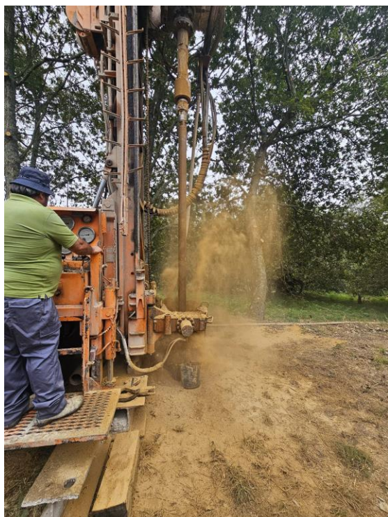
Fotografia 1 e 2 – Início dos trabalhos de perfuração; Colocação do tubo de aço carbono 220mm.
