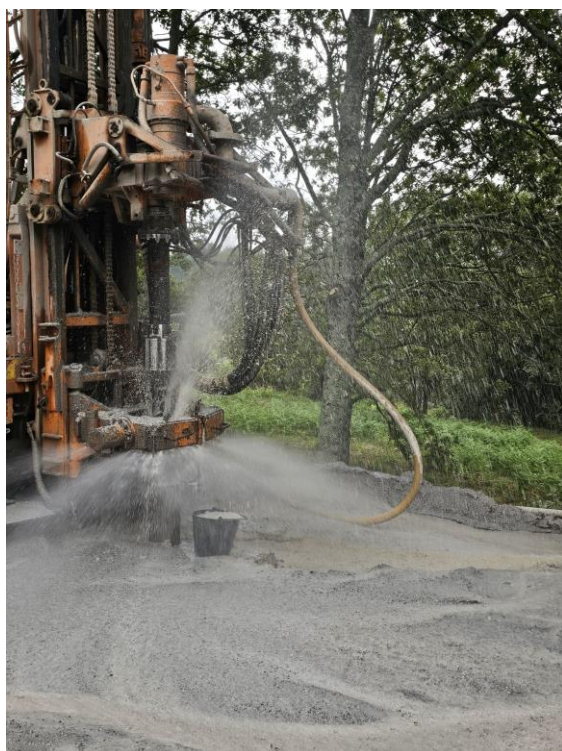
Fotografia 7 e 8 – Trabalhos de perfuração, nível produtivo intersetado
