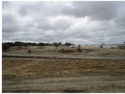
Foto 2 – Vista geral do terreno (NO-SE)
