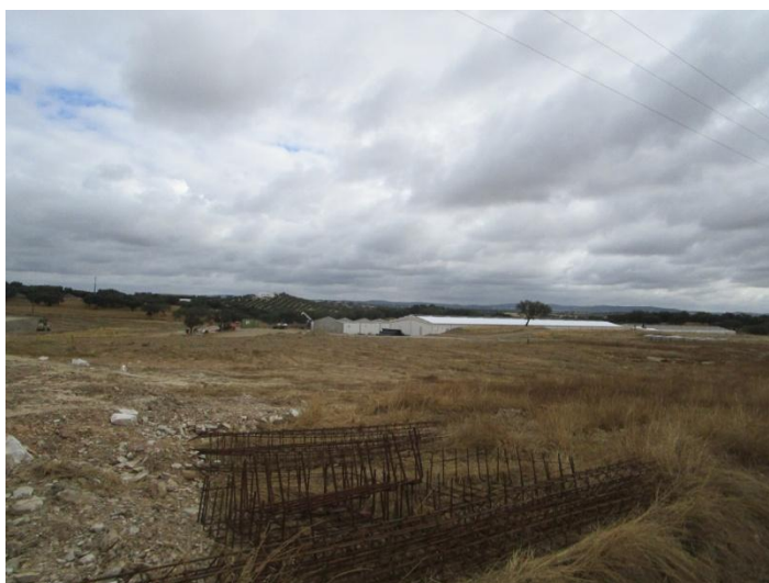
Figura 1 - Vista geral do terreno (visibilidade média) com a construção dos pavilhões em curso (1ª fase)
