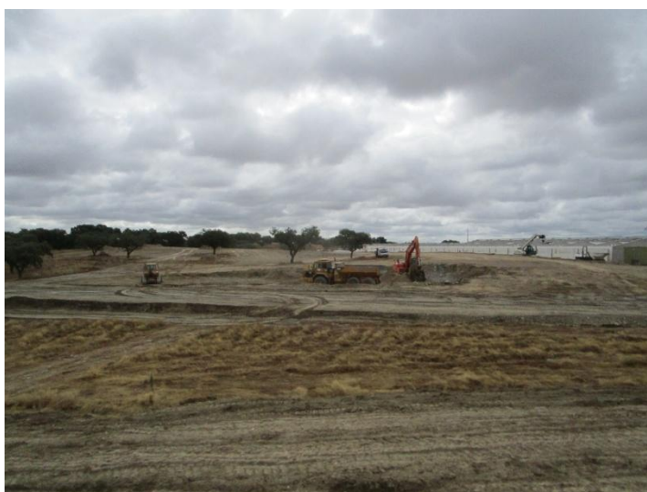
Figura 2 - Vista geral do terreno (solo artificializado) com a construção dos pavilhões em curso (1ª fase)
