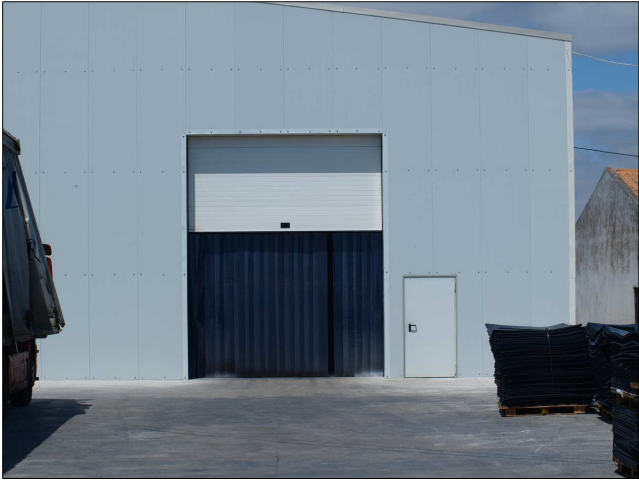
FOTO DO EXISTENTE - Nascente
