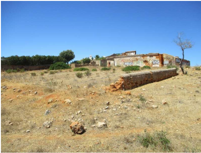
Figura 23- Vista geral da Quinta dos Arcos e dos seus muros de divisão de propriedade.
