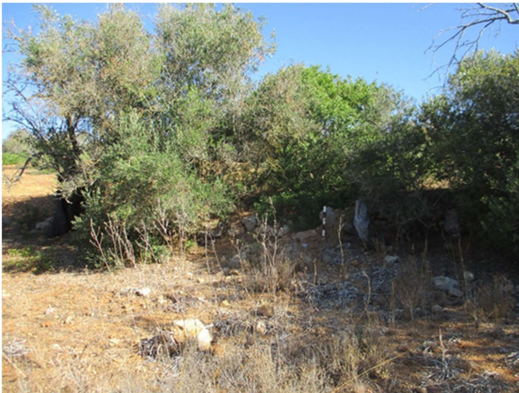
Figura 52- Vista geral do remanescente de muro de contenção de terras, na Quinta dos Poços 13
