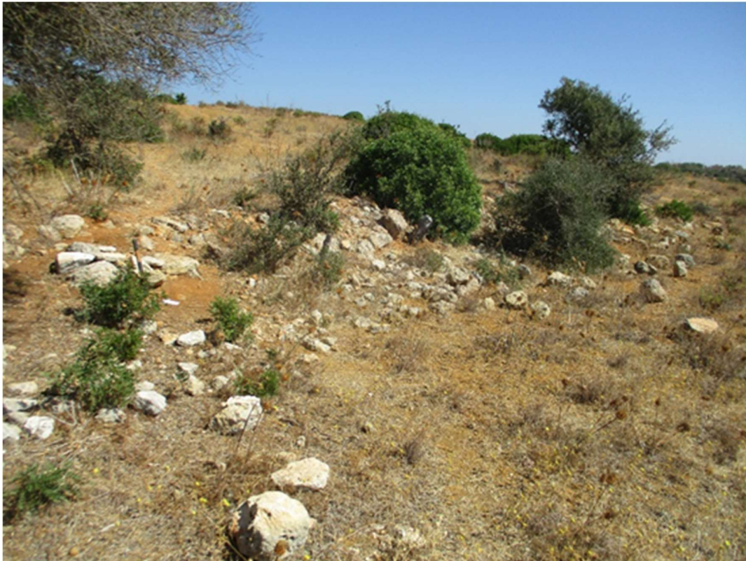
Figura 55- Vista geral do alçado Sul do muro de contenção de terras na Quinta dos Poços 14
