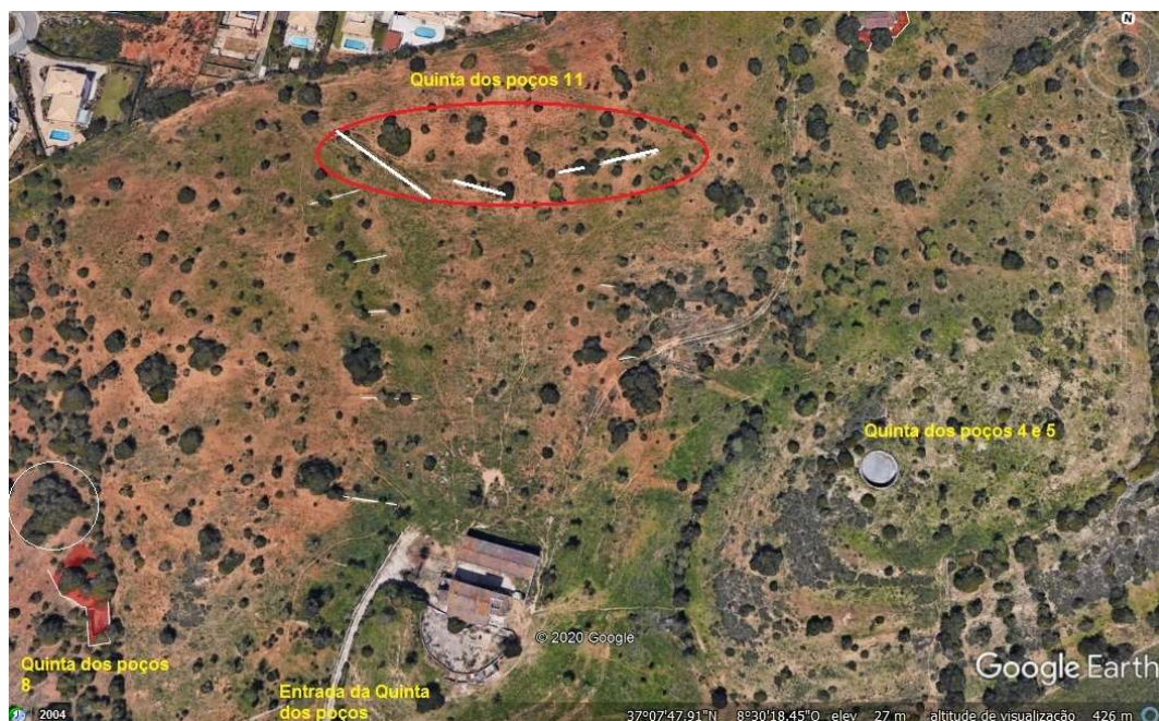
Figura 39- Localização de muros de contenção de terra na Quinta dos Poços 11
