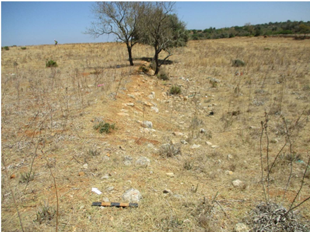
Figura 62- Vista geral do topo do muro de contenção de terras, Quinta dos Arcos 5
