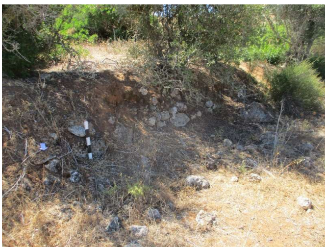
Figura 28- Muro de contenção de terras na área Oeste da Quinta dos Arcos 2 (sitio 4)
