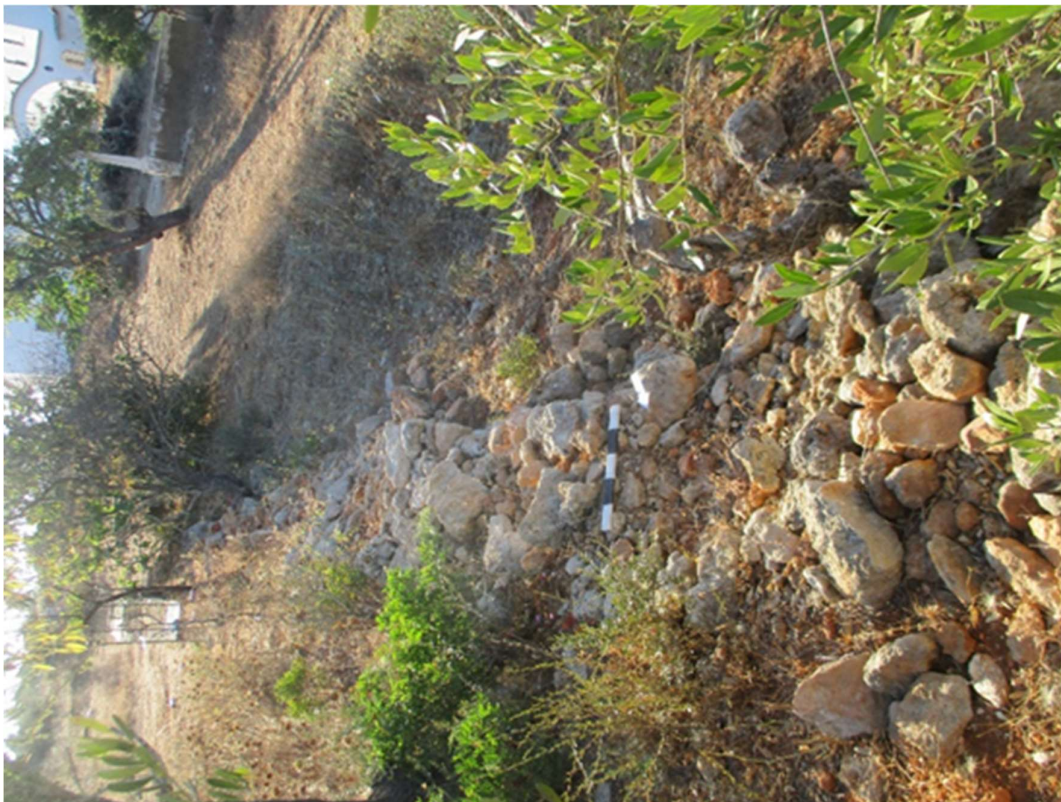
Figura 47- Vista de plano de muros de contenção de terras na Quinta dos Poços 12
