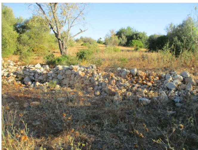
Figura 45- Alçado Sul de muro de contenção de terras na Quinta dos Poços 12
