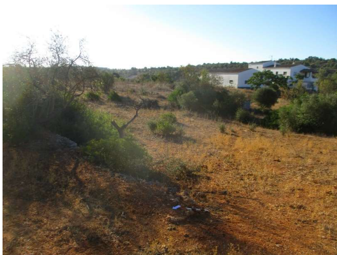
Figura 46- Vista geral de muro de contenção coberto por vegetação, na Quinta dos Poços 12
