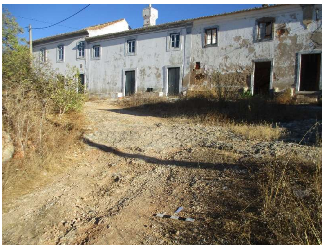
Figura 13- Vista geral da residência principal da Quinta dos Poços 7
