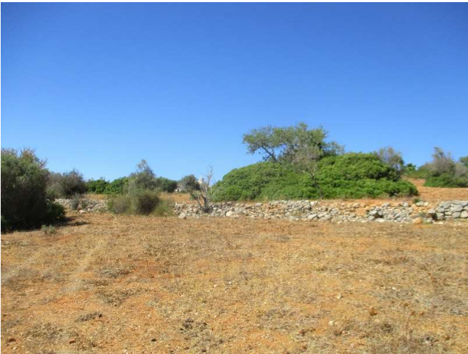
Figura 41- Vista geral de muro de contenção de terras na Quinta dos Poços 11
