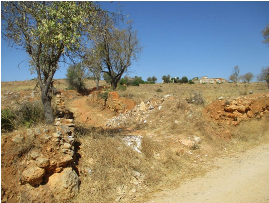
Figura 57- Vista geral do limite sul da Azinhaga que faz a ligação à Quinta dos Arcos (Quinta dos Arcos 4)
