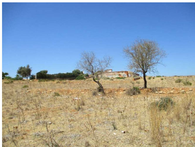
Figura 61- Vista geral do muro de contenção de terras, Quinta dos Arcos 5
