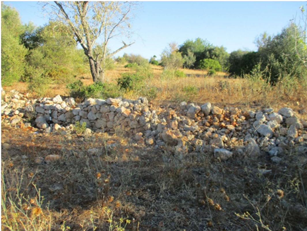
Figura 45- Alçado Sul de muro de contenção de terras na Quinta dos Poços 12
