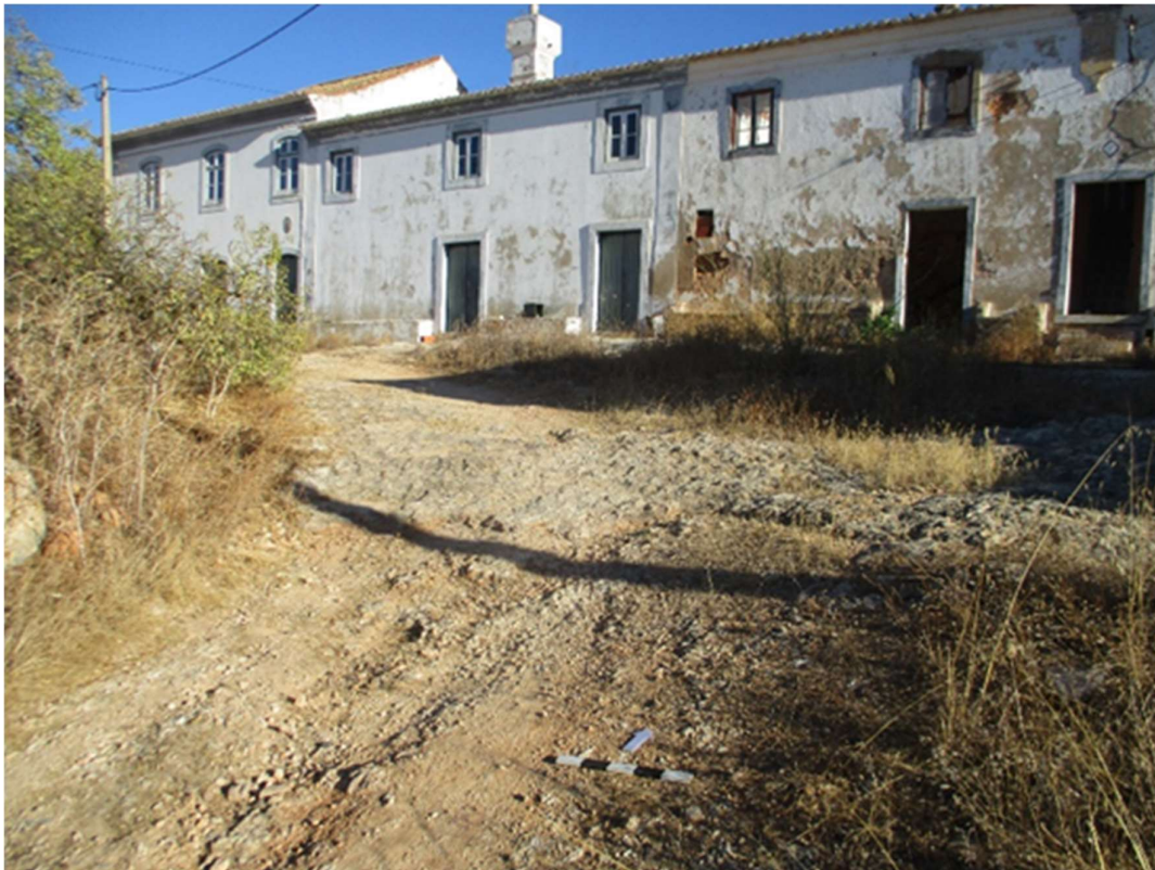
Figura 13- Vista geral da residência principal da Quinta dos Poços 7
