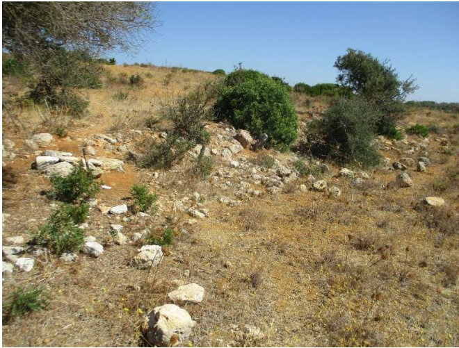
Figura 55- Vista geral do alçado Sul do muro de contenção de terras na Quinta dos Poços 14
