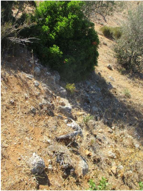
Figura 33- Plano de muro de contenção situado a meio do vale a Norte da Quinta dos Arcos 3
