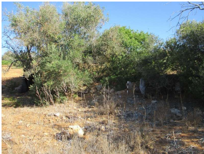
Figura 52- Vista geral do remanescente de muro de contenção de terras, na Quinta dos Poços 13
