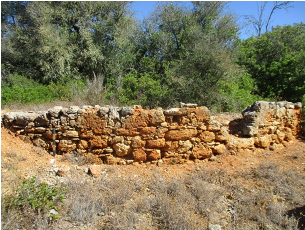
Figura 18- Murete de contenção de terras da Nora a Sul
