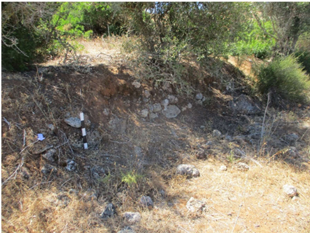
Figura 28- Muro de contenção de terras na área Oeste da Quinta dos Arcos 2 (sitio 4)
