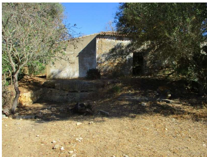
Figura 36- Vista geral da entrada do casal Quinta dos Poços 10
