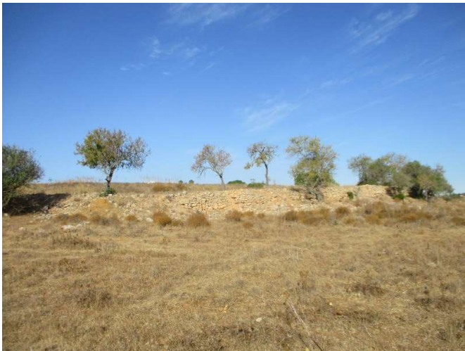
Figura 34- Vista geral de muro de contenção de terra a delimitar a base Nordeste da colina a Nordeste da Quinta dos Arcos 3
