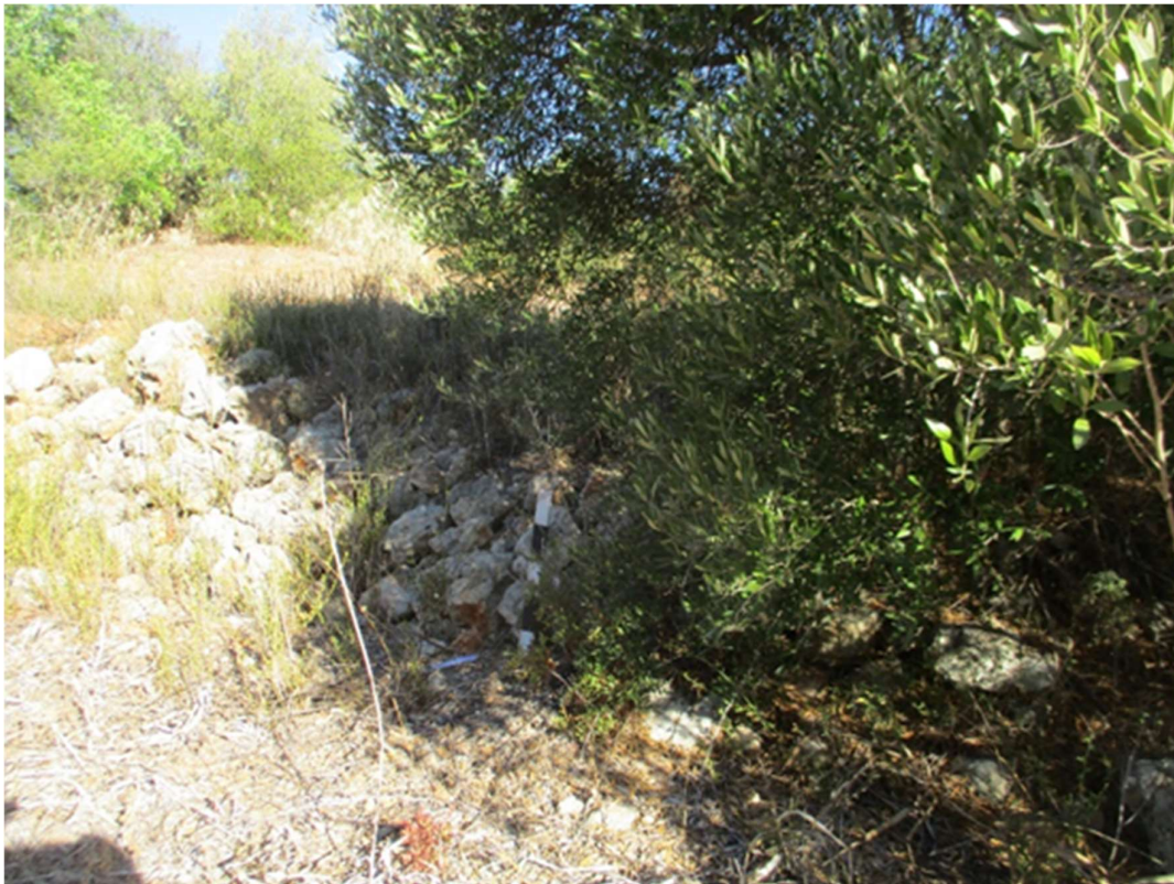
Figura 50-Alçado Sul de muro de contenção de terras junto ao caminho, Quinta dos Poços 13
