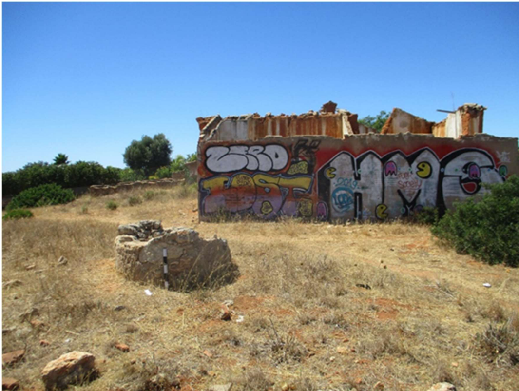
Fi gura 66-Vista geral de possível estrutura de combustão a Este da Quinta dos Arcos
