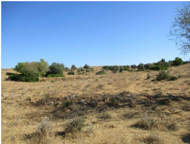
Figura 32- Vista geral de muro de contenção na base do vale a Norte da Quinta dos Arcos 3
