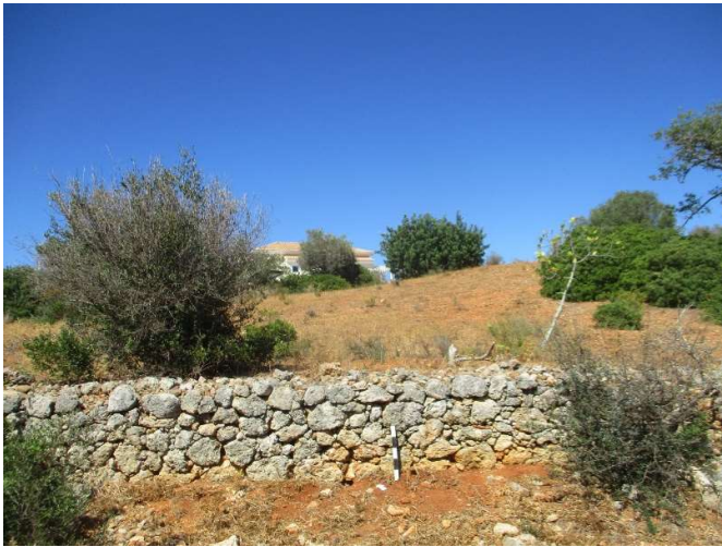
Figura 40- Alçado Sul de muro de contenção de terras na Quinta dos Poços 11
