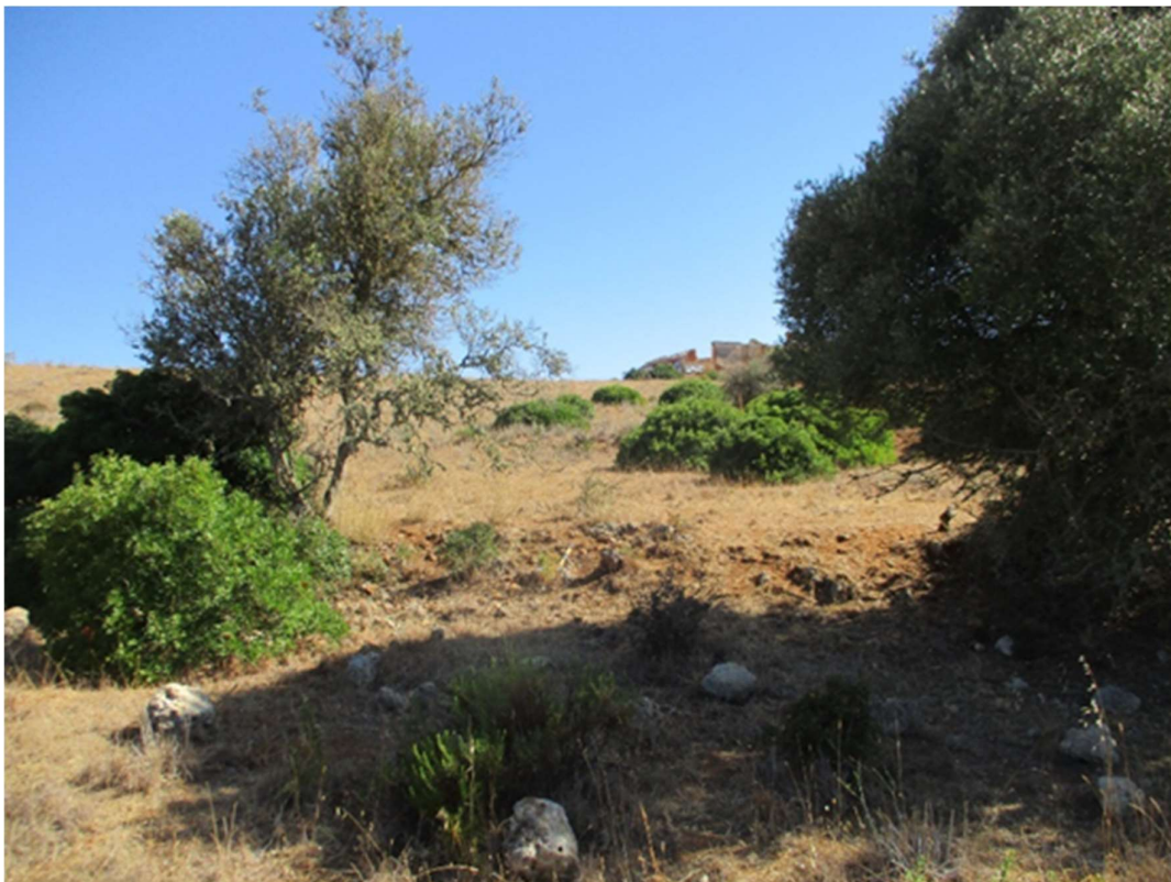
Figura 31- Vista geral de muro de contenção de terras no topo da colina a Norte da Quinta dos Arcos 3
