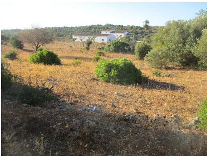
Figura 44- Vista geral do plano de um muro de contenção de terra a Norte da entrada da Quinta dos Poços
