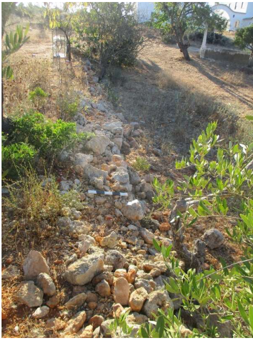
Figura 47- Vista de plano de muros de contenção de terras na Quinta dos Poços 12
