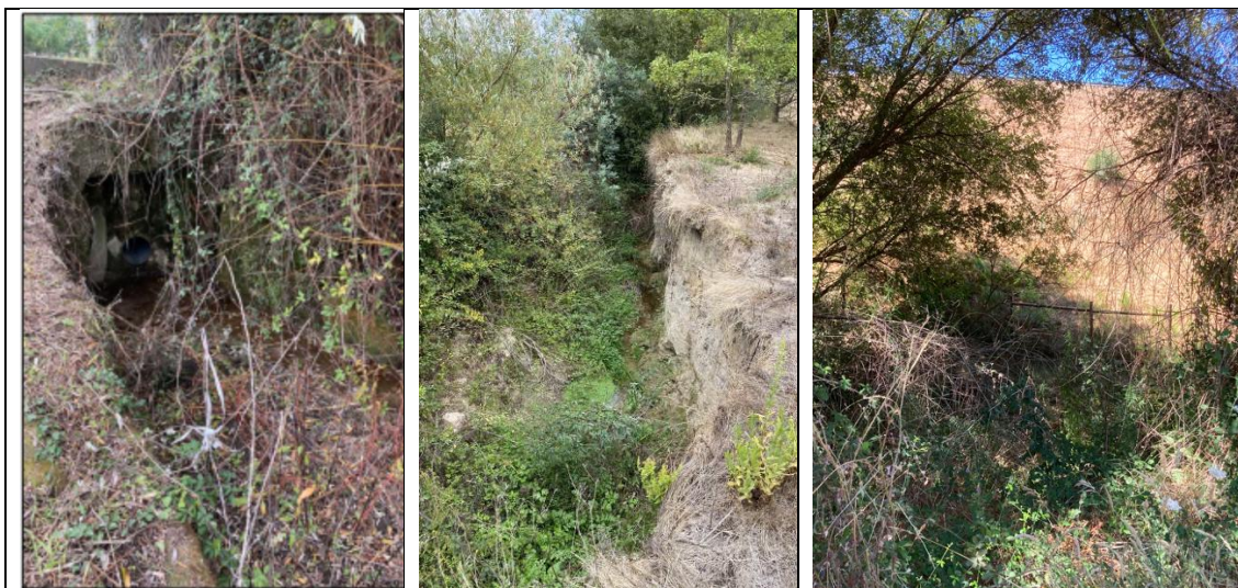
Figura 4.7.4 – Pontos descarga de águas pluviais (PD1, PD2 e PD3).
