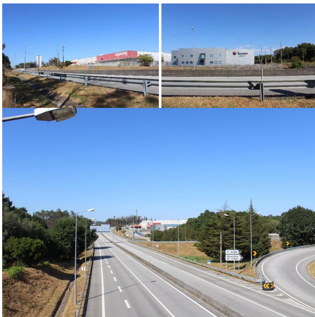
Figura 4.10.4 – Vistas da ponte sobre a A35 para o Parque de Sampaio
