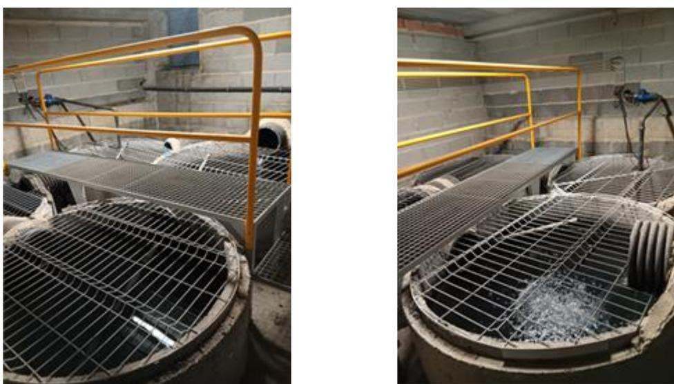
**Figura 10.** Tanques de recolha de águas pluviais
