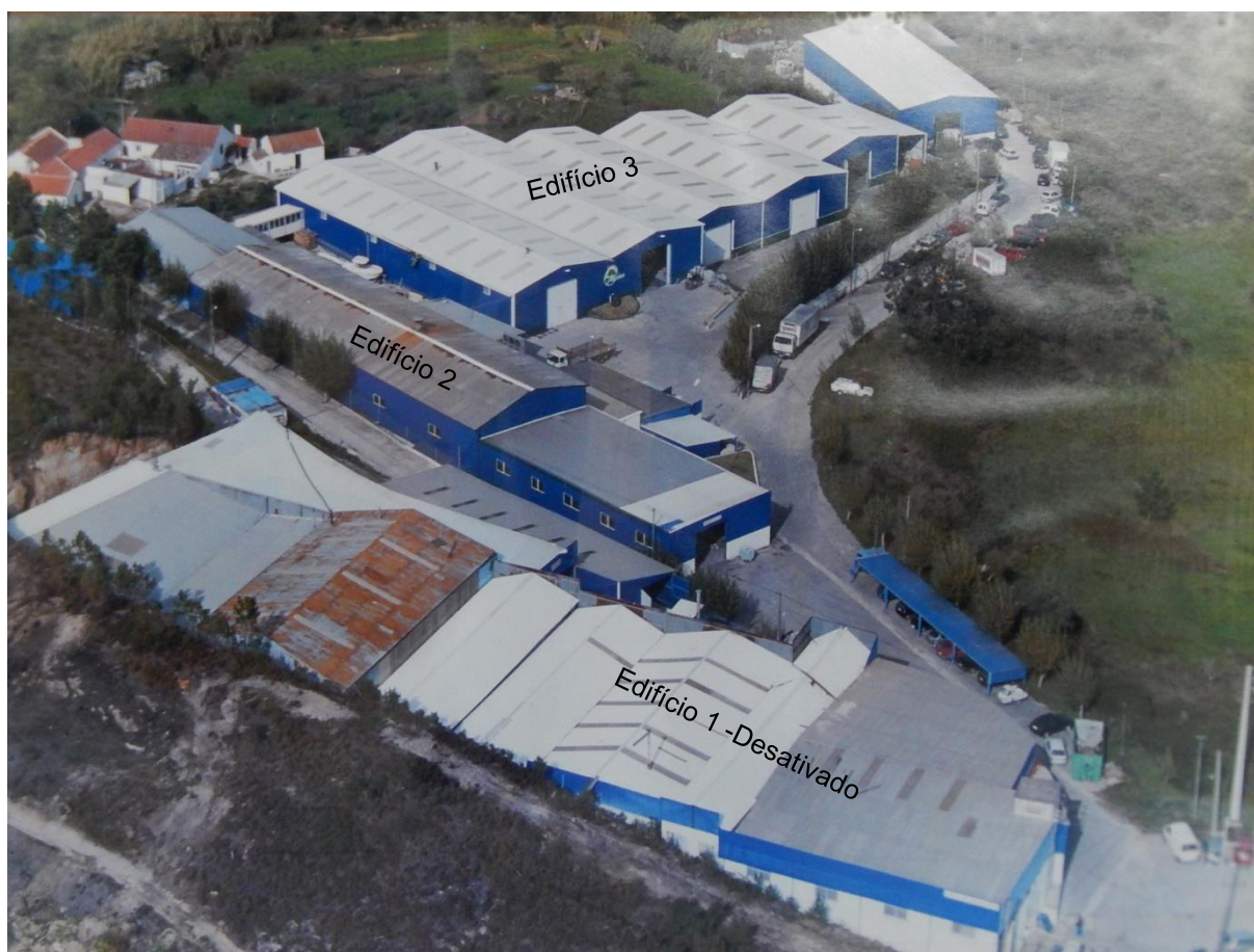
Figura 4 - Vista Geral da Instalação
