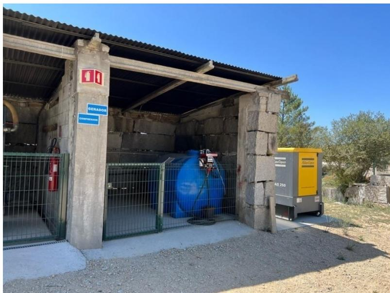
Figura 22. Pormenor do sistema de depósito de gasóleo, temporário, de apoio ao gerador.
