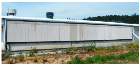
Figura 1. Exemplo de um painel evaporativo ou cooling existente numa exploração avícola do Grupo Lusiaves.
