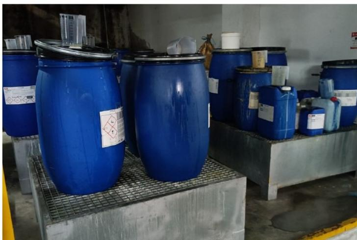
Figura 2 – Armazenamento de produtos químicos da tinturaria em bacias de retenção.
