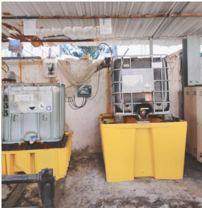
Figura 4 – Armazenamento de produtos químicos da ETAR em bacias de retenção.
