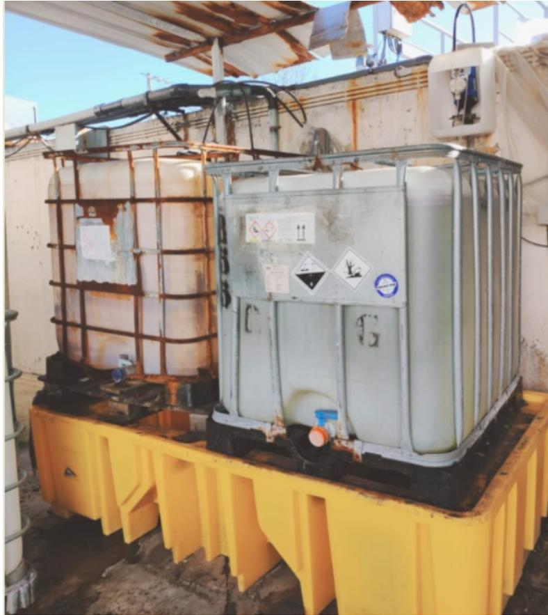
Figura 3 – Armazenamento de produtos químicos da ETAR em bacias de retenção.
