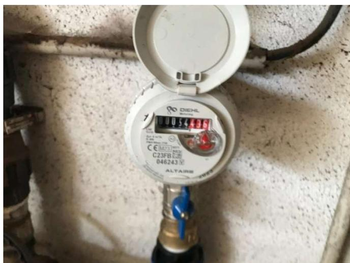
Foto 2: Contador instalado
