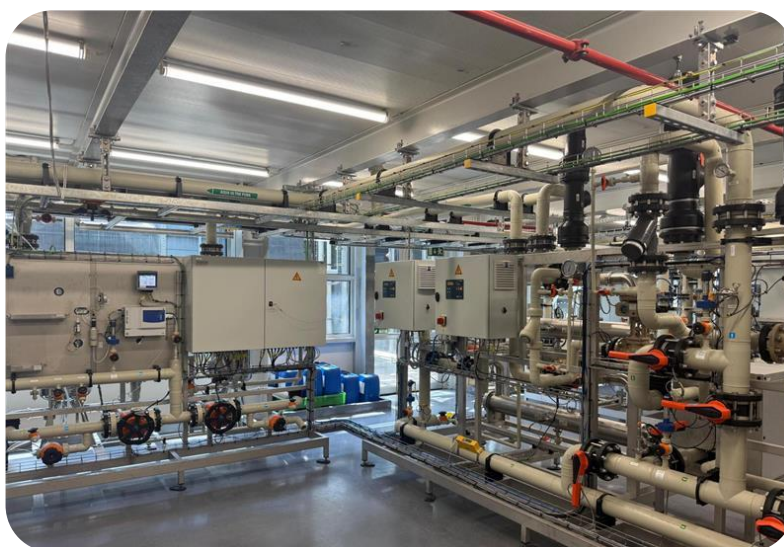
Figura 20. Exemplo da Instalação de produção de DIWater.
