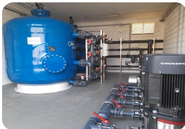
Figura 19. Exemplo dos tanques de armazenamento de água e da Central de Desferrização.
