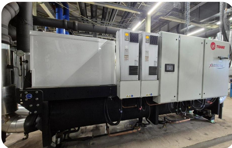
Figura 14. Exemplo da bomba de calor.
