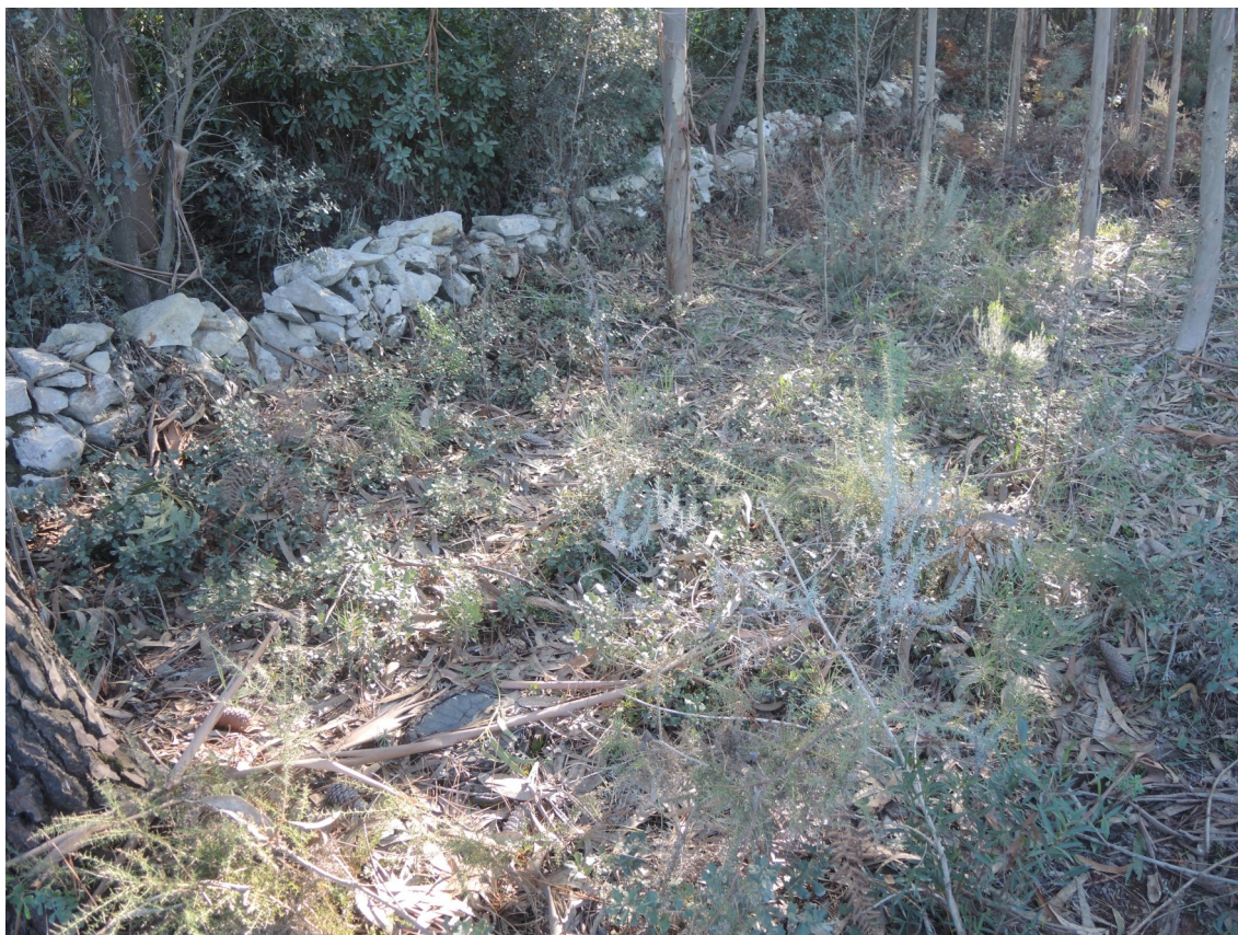
Fot. 9 – Ocorrência 1—Casal Farto, muro de pedra seca.
