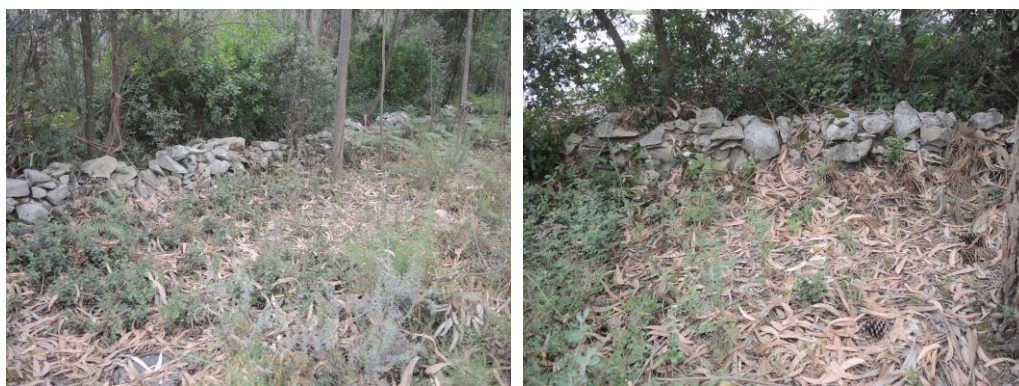
Foto 1 a 3 – Muros de pedra seca.
