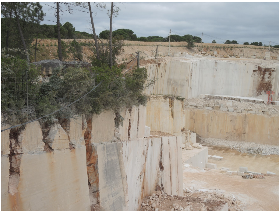
Fot. 5 – Zona com talude artificial e cortina arbórea (ao fundo) no limite NO da exploração.
