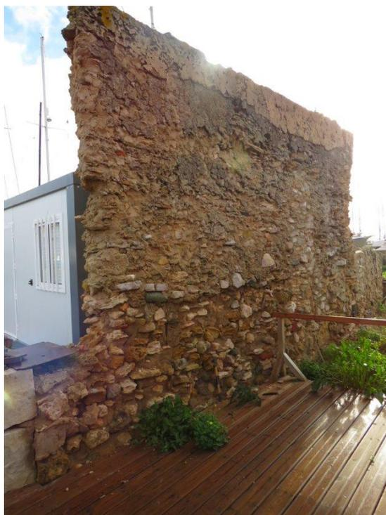
Figura 63 – Parede Oeste (parede original) do Moinho do Sobradinho com revestimento em cimento e ferro.
