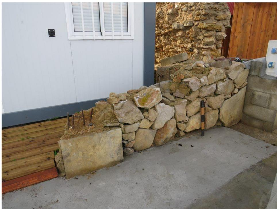
Figura 62 – Exemplo de um dos muros do Moinho do Sobradinho, reconstruído com pedra, cimento e ferro.
