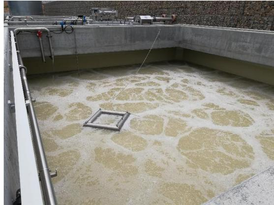
Figura 3. Exemplo de aplicação de descarregadores flutuantes VentilAQUA.
