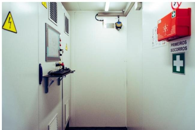
Foto 6 - Sala de controlo e comando, visível o medidor de gás sulfídrico na parte superior direita e o PC de comando embutido no quadro elétrico
