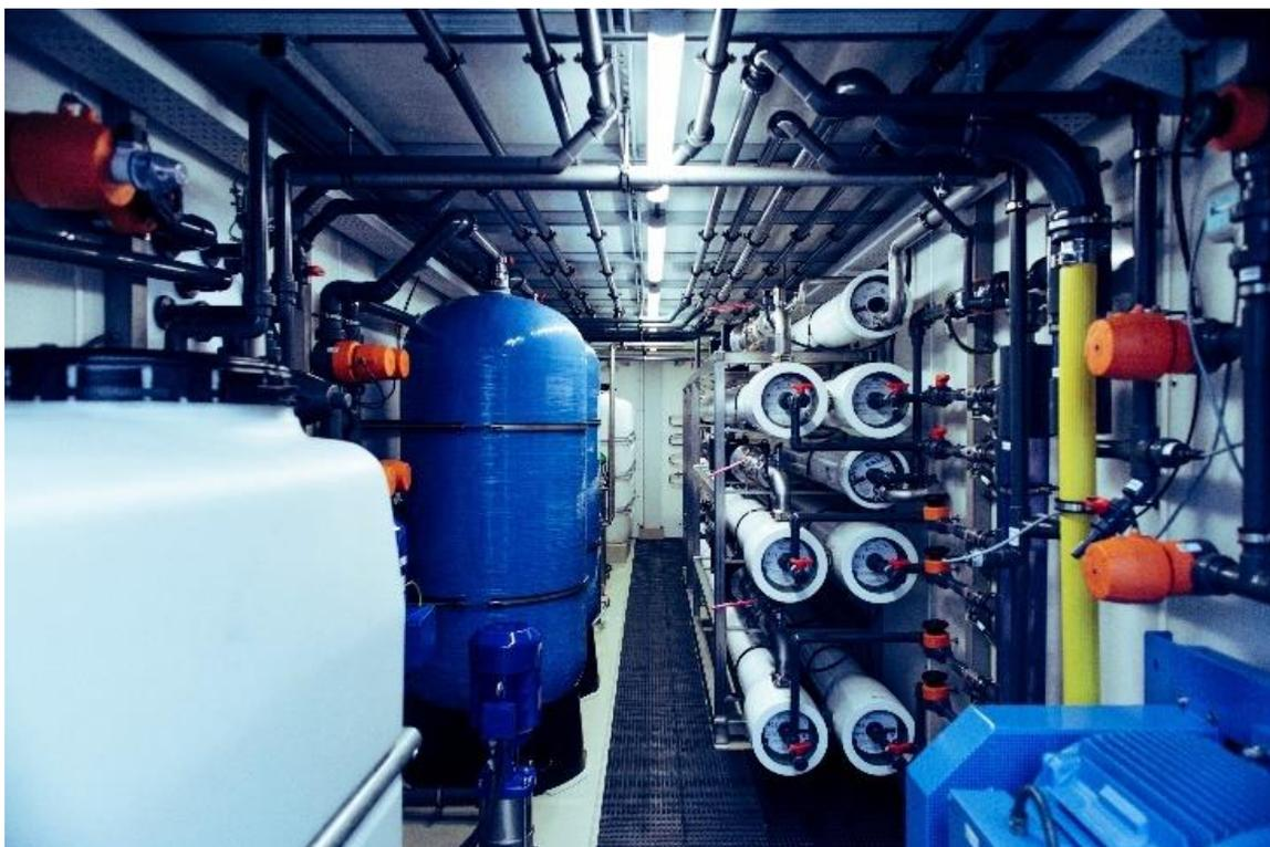
Foto 3 - Vista interior de um contentor de OI de 200m<sup>3</sup>/d com alinhamento dos blocos da 1ª, 2ª e 3ª fase
