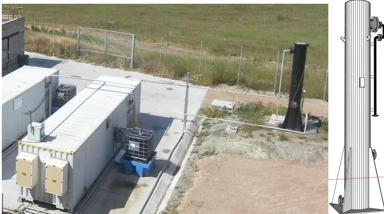
Foto 4 - Exemplo de localização e esquema da torre de lavagem de permeado
