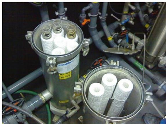
Foto 1 - Estação de micro-filtração com dois recipientes com filtros de cartucho.
