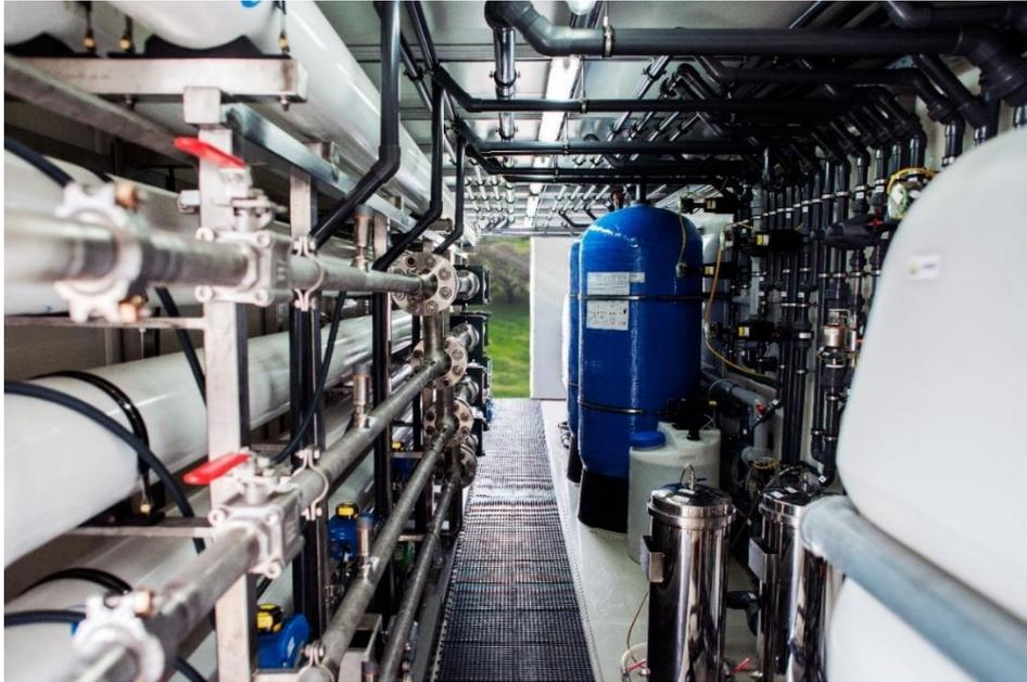
Foto 7 - Vista interior de um contentor de Osmose Inversa instalado num AS
