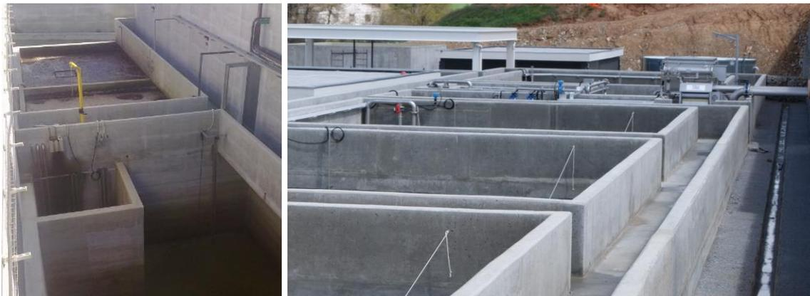
Figura 4. Exemplo de SmartSBR® com tanques em Betão.
