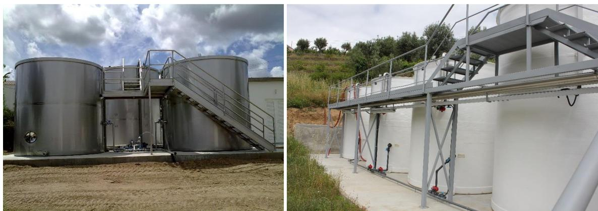
Figura 5. Exemplo de SmartSBR® com tanques Externos (Aço Inox & Fibra de Vidro).
