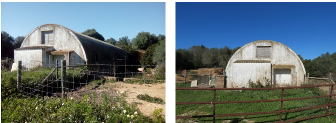
Figura 20 e Figura 21 – Fotos dos edifícios da Casa de Apoio Agrícola.
