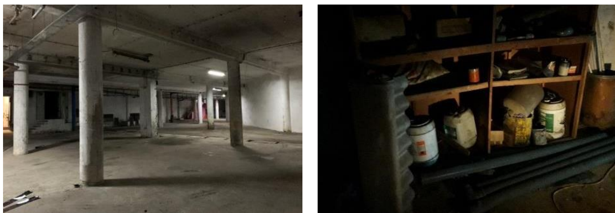
Figura 2.8 – Piso de cave dos armazéns
