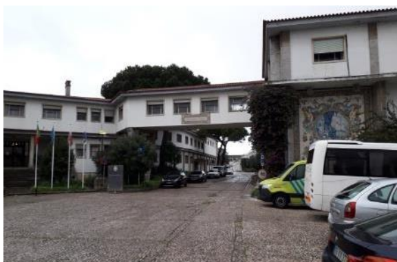
Figura 2.4 – Edifícios dos serviços administrativos da C.M.O.
