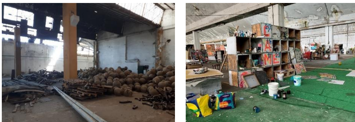
Figura 2.5 – Interior do edifício a E no pátio (à esq.) e interior do edifício a W do pátio (à dir.)
