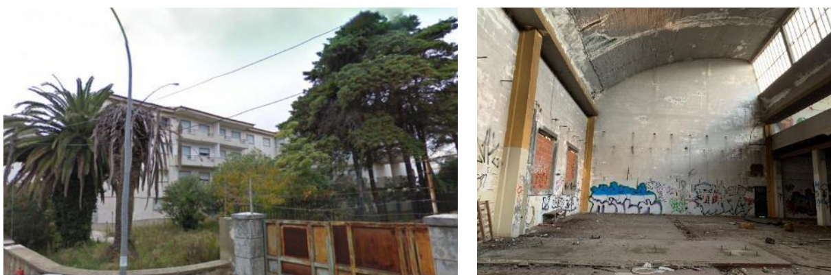
Figura 2.9 – Edifícios situados a Sul, fora da área da Fundição
