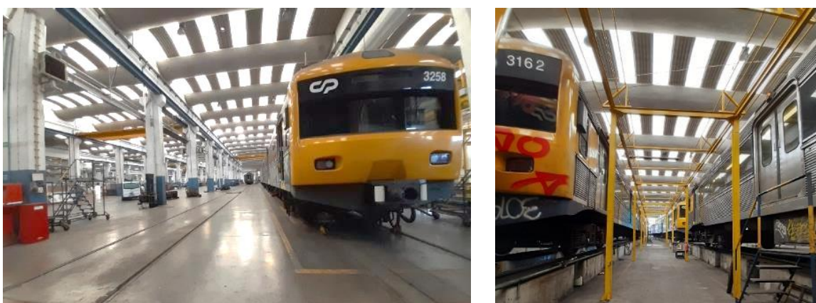
Figura 2.11 – Zona N do edifício da CP/EMEF
